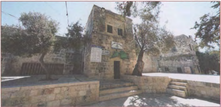
İslam Bey Halvethanesi'nin Aksa avlusuna bakan cephesi
