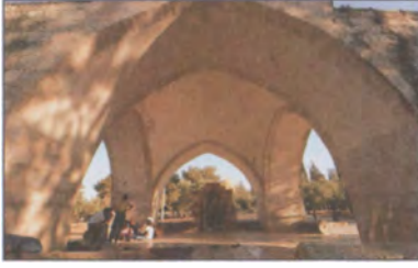
Dört ayaklı baldaken açık ders mahalleri
