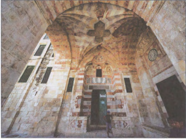
Kayıtbay Medresesi ana kapı
