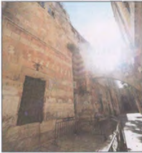
Arguniyye Medresesi'nin Ak-sa dışına bakan cephesinde sol pencere içinde Emir Argun'un türbesine ait hacet penceresi
