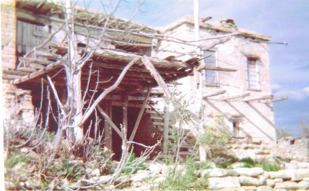
16: Karaisalı'da eski bir köy evinden görünüş
