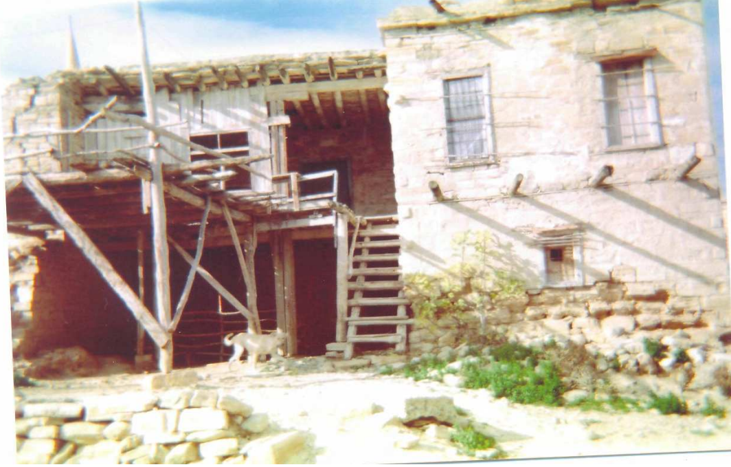
15: Karaisalı'da eski bir köy evinden görünüş
