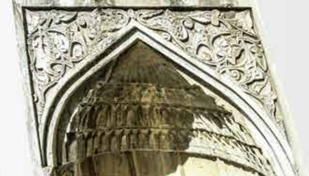
(Resim 4) İlyas Bey Camii, kuzey cephesindeki niş, ayrıntı
