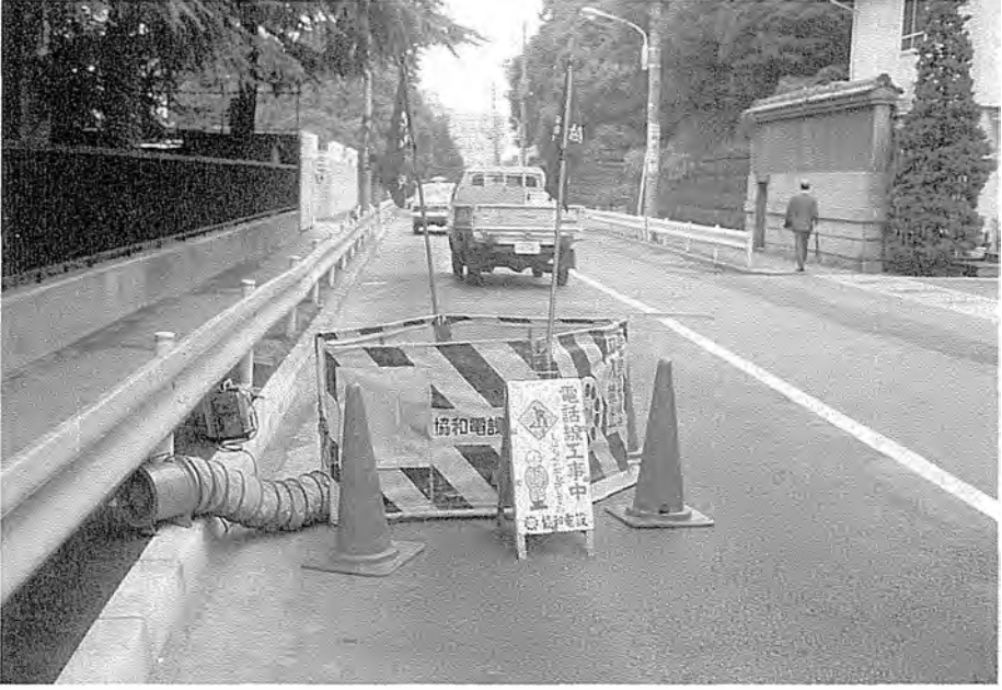
RESİM 32-1: Yol altındaki PTT kanal ve hatlarının sürekli bakımı. Tokyo: Roppongi.
