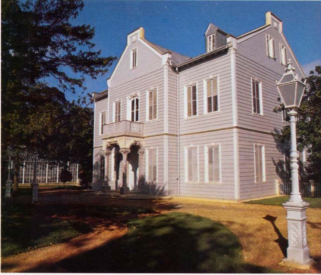
KASR-I HÜMAYÛN GİRİŞ CEPHESİ
