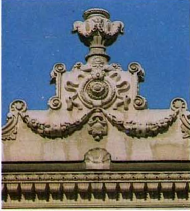
MERASİM KÖŞKÜ CEPHESİNDE TAŞ TEPELİK
