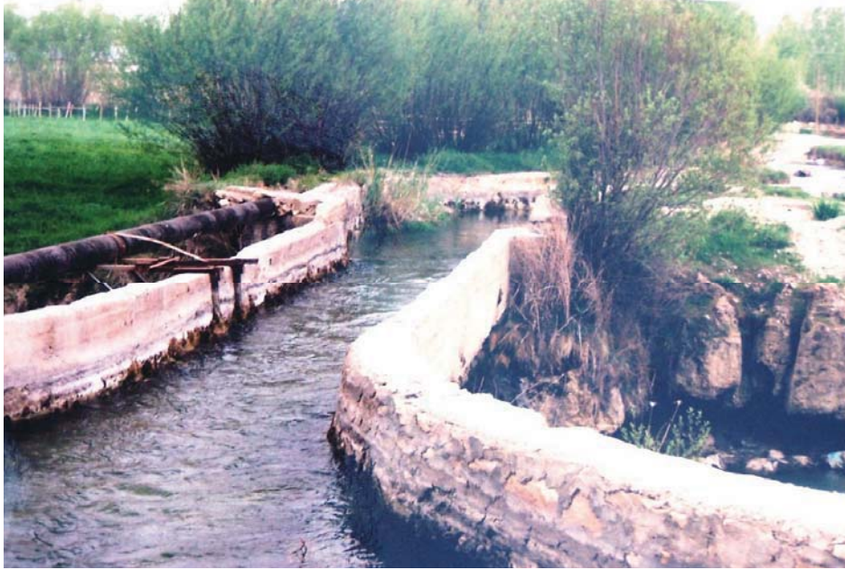
Resim 4- Minua Kanalı'nın Hoşap Çayı üzerinden geçtiği beton köprü
