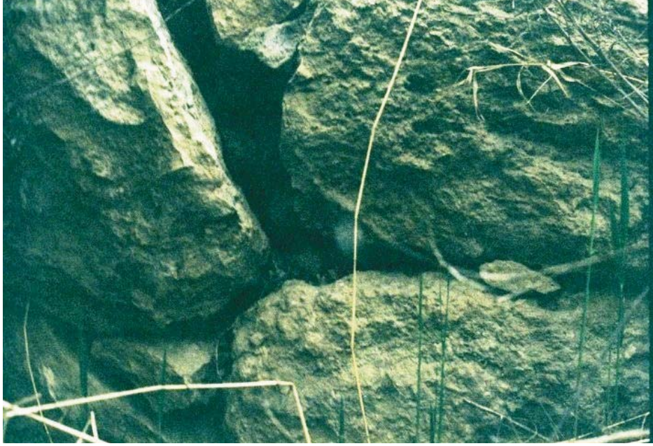
Resim 5- Beton köprünün temelindeki kyklopik taşlar
