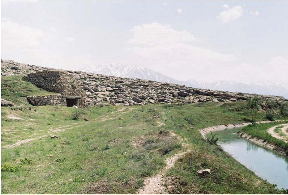
Resim 22- Kadembastı, eski ve yeni kanal
