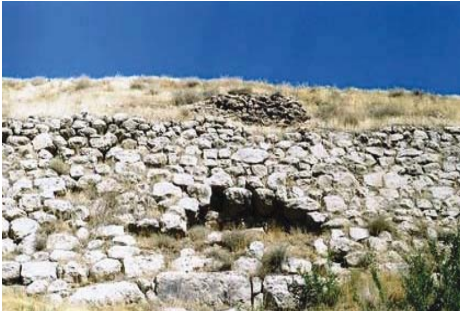
Resim 18 Kadembastı, Ortaçağ duvarı
