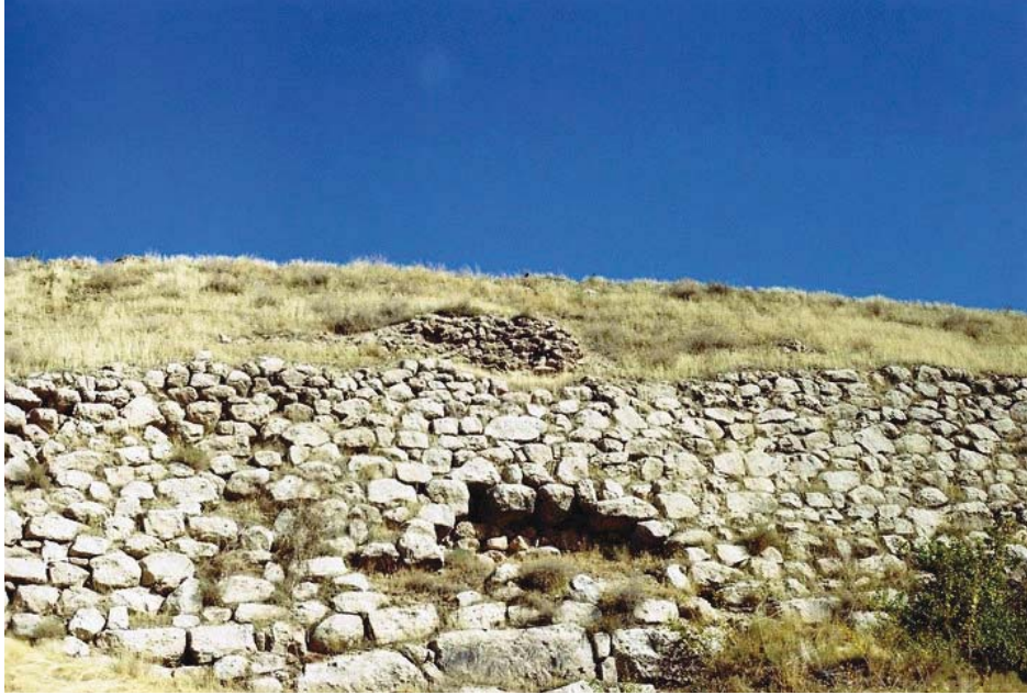
Resim 17- Kadembastı, Ortaçağ duvarı
