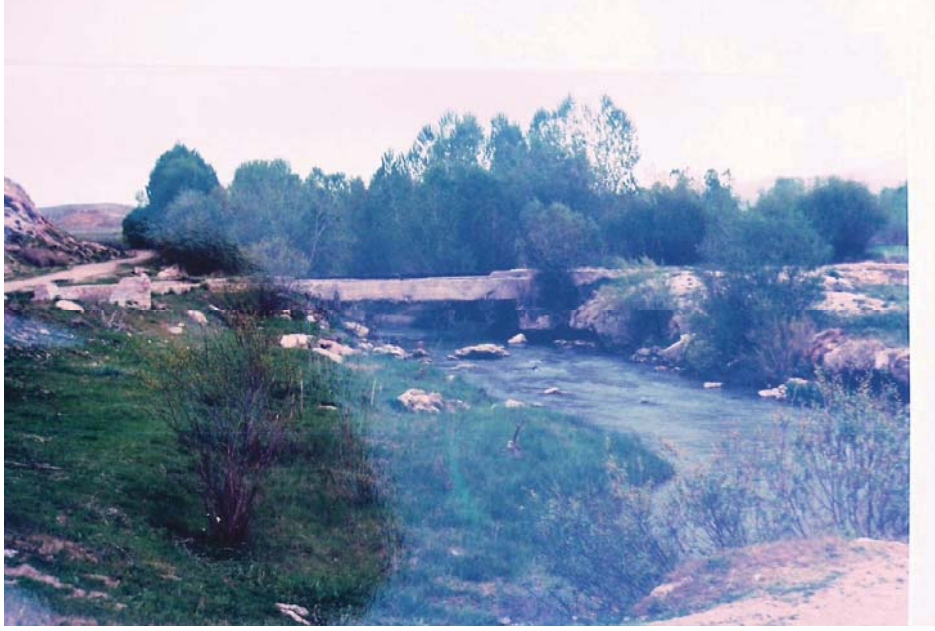
Resim 3- Aşağı Kaymaz Köyü, Minua Kanalı'nın Hoşap Çayı üzerinden geçtiği beton köprü
