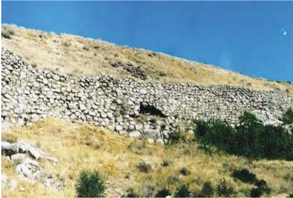
Resim 16- Kadembastı, kanal destek duvarları
