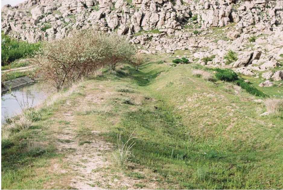
Resim 20 , Kadembastı, eski ve yeni kanal
