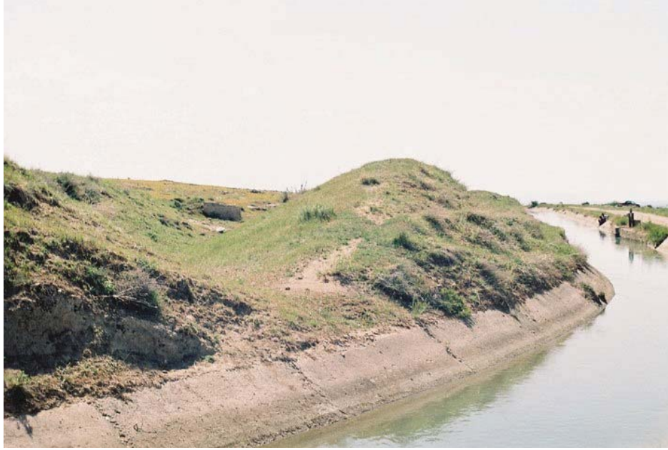
Resim 21- Kadembastı, eski ve yeni kanal
