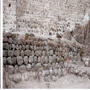
Foto 41. Pasinler (Hasankale) Kalesi Urartu Sur Duvarı
