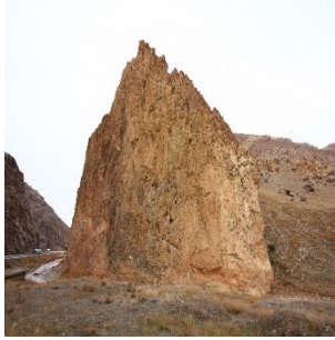
Foto 17. Dellal Kaya Basamaklı Su Tüneli
