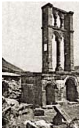
Ağuri qəbirüstü abidəsi
