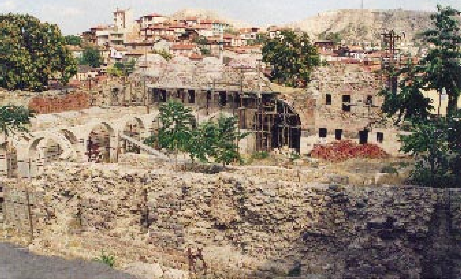
317. Resim: Suluhan, güneybatıdan genel görünüş
