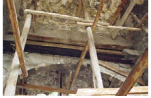
300. Resim: Suluhan, giriş kapısına ait taş, ahşap ve dövme demir aksamlar
