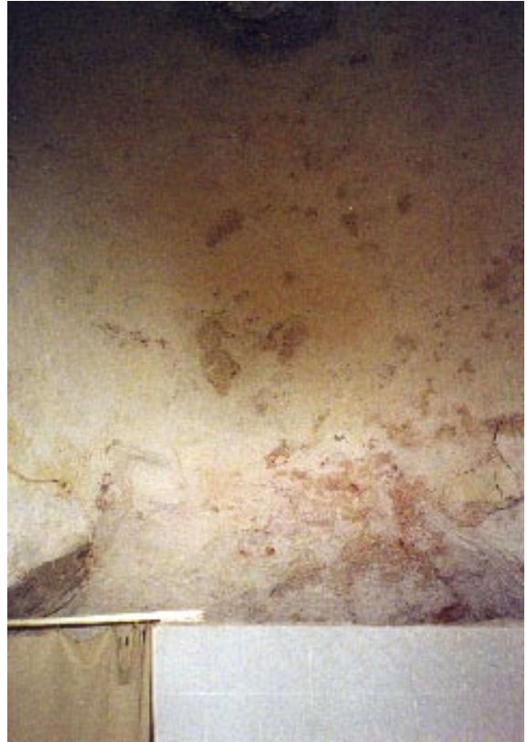
342. Resim: Rüstem Paşa Hamamı, soğukluğun doğu köşesi ve üst örtü
