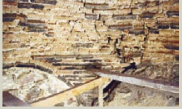
310. Resim: Suluhan, birinci kat odalarının kubbe ve geçiş sistemlerindeki orijinal tuğla Örgü
