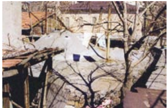
325. Resim: Paşa Hamamı, sıcaklığın güneybatıdan görünüşü
