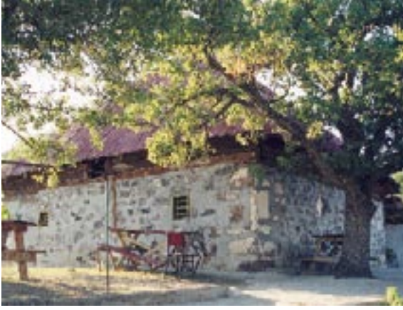
253. Resim: Kabaca Köyü Kaygusuz Abdal Türbesi, güneydoğudan genel görünüş
