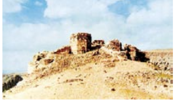
1. Resim: Beypazarı kent merkezinin 23 km. güneyinde yer alan Tabanoğlu Kalesi
