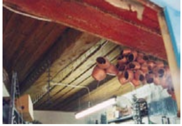
78. Resim: İncili Camii, harım ve dükkân katları arasındaki ahşap döşemeden görünüş
