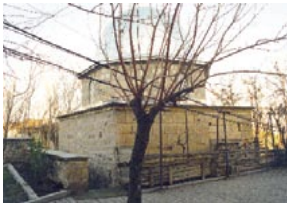
240. Resim: Kuyumcutekke Köyü Kara Davut Türbesi, kuzeybatıdan genel görünüş
