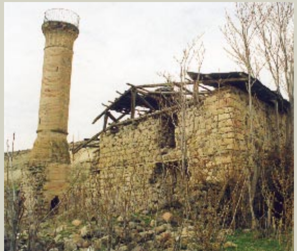
48. Resim: Eski Derbendçik Camii, gineydoğudan görünüş
