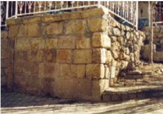
361. Resim: Çınar Sokağı Çeşmesi, güneybatıdan genel görünüşü
