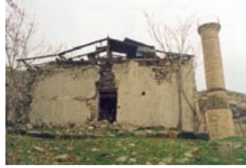
51. Resim: Eski Derbendçik Camii, kuzey cephe
