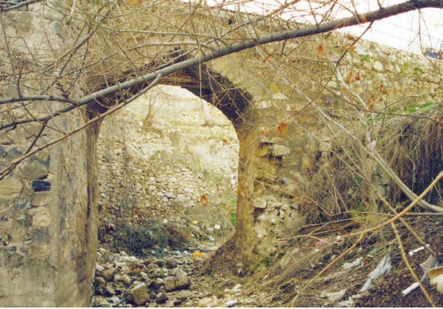
349. Resim: Karcıkaya Köprüsü, mansap cephesi
