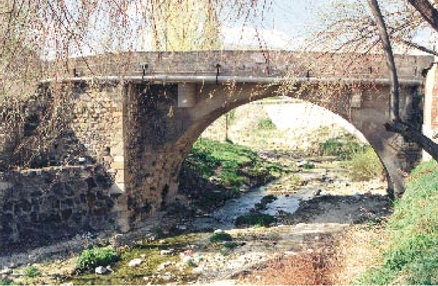
347. Resim: Hacilar Köprüsü, mansap cephesi
