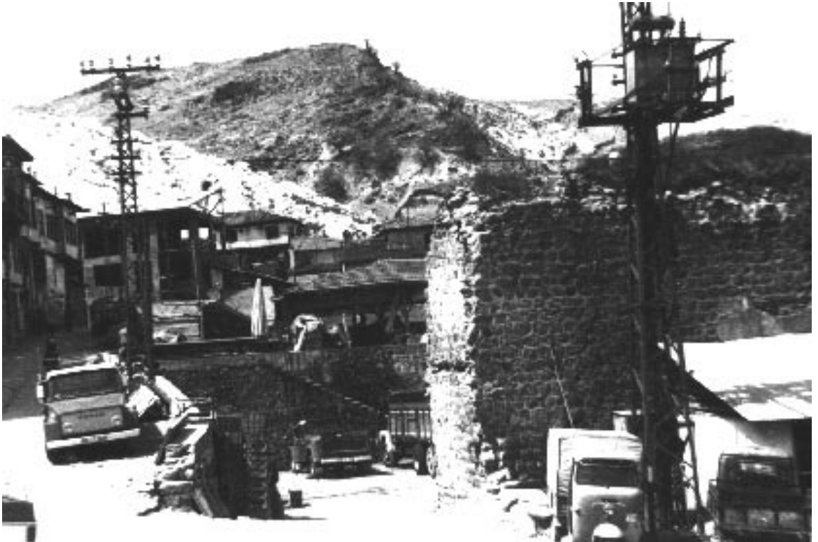
285. Resim: Suluhan, doğu cephenin yıkık olan güney köşesi, 1976 (VGM Arşivi'nden)
