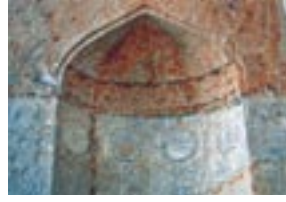
117. Resim: Kırşunlu Camii, giriş kapısının doğu kenarındaki mihrabiye'nin kavsarası
