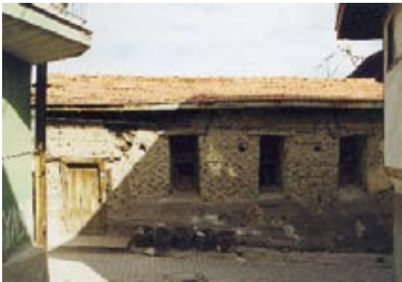
156. Resim: Beytepe Sokağı Mescidi, batı cephe
