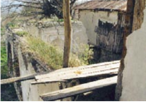
198. Resim: Bağözü Köyü Eski Camii, kuzeydoğudan genel görünüşü
