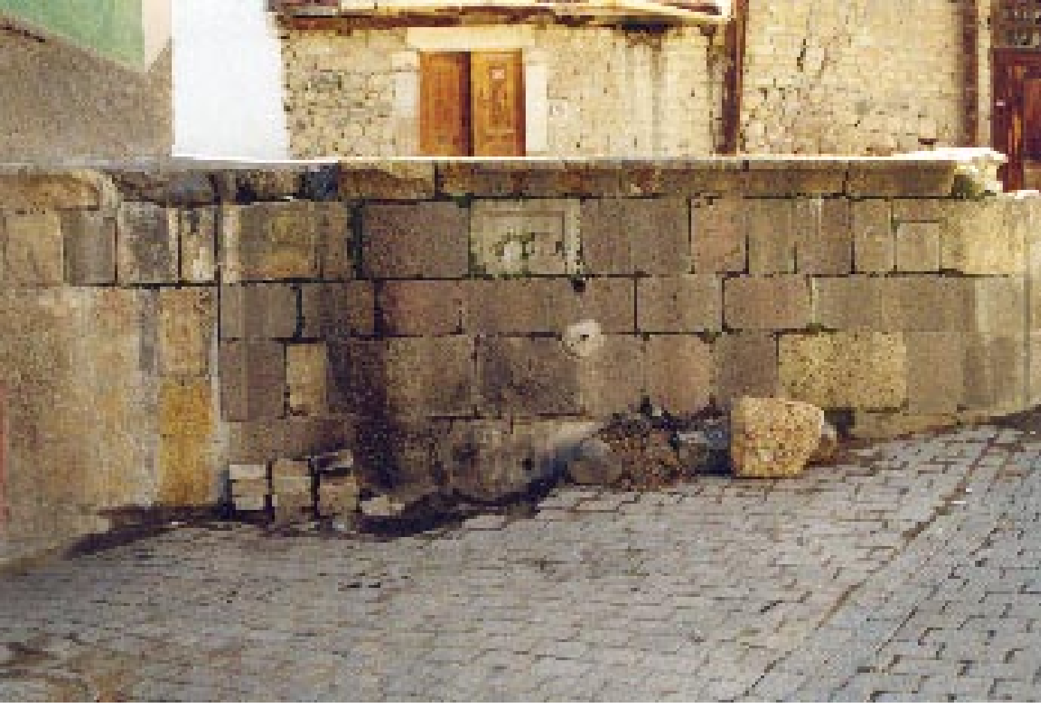
351. Resim: Acı Çeşme, cepheden görünüş
