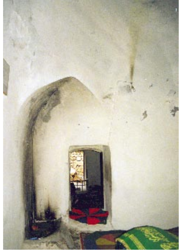
238. Resim: Karaca Ahmet Türbesi, kubbeli mekâna giriş
