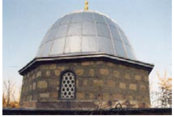
242. Resim: Kuyumcukteke Köyü Kara Davut Türbesi, üst örtüden görünüş
