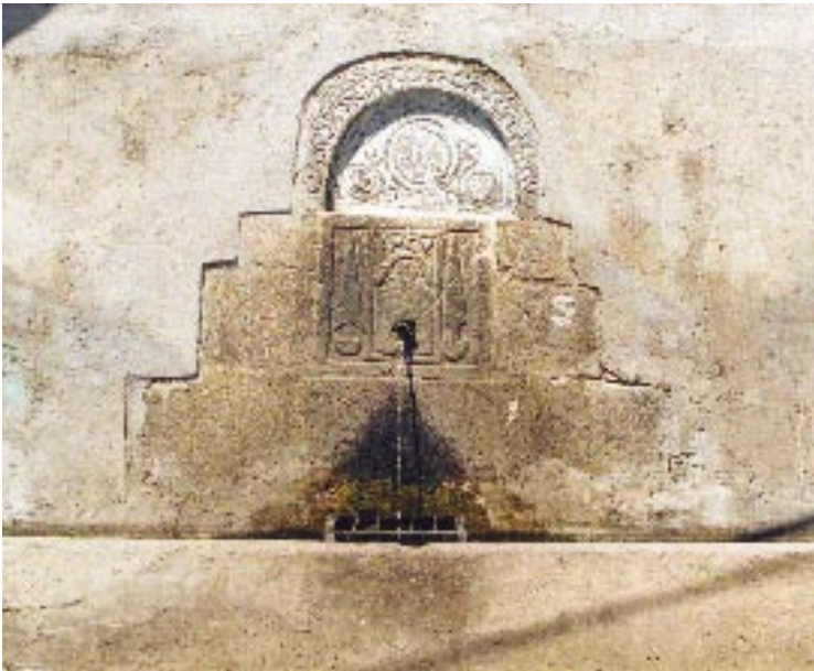
388. Resim: Karaşar Beldesi Simit Pınarı Çeşmesi, cepheden görünüş
