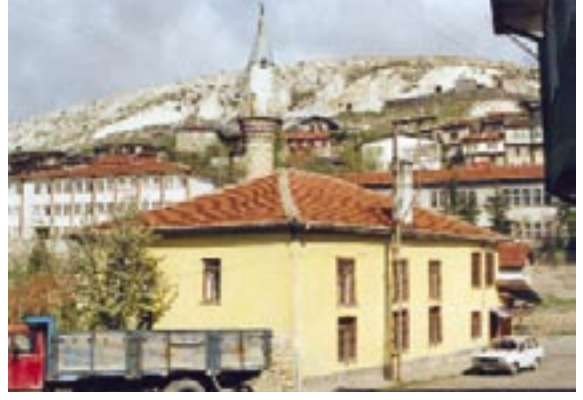
60. Resim: İmaret Camii, güneydoğudan genel görünüş
