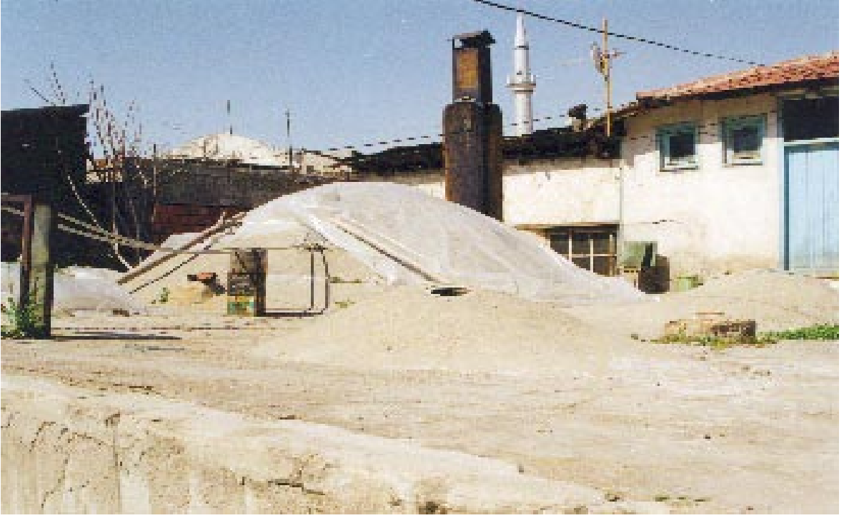
338. Resim: Rüstem Paşa Hamamı, üst örtünün güneydoğudan görünüşü
