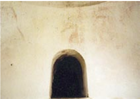
330. Resim: Paşa Hamamı, sıcaklık ile su deposu arasında yer alan pencere
