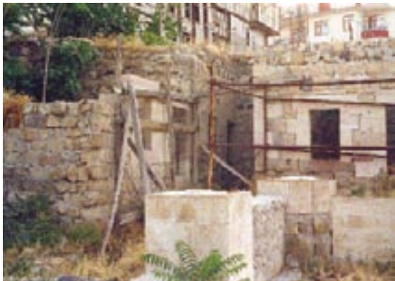
315. Resim: Suluhan, kazı sonrası güney kanadın batı köşesindeki zemin kat odaları
