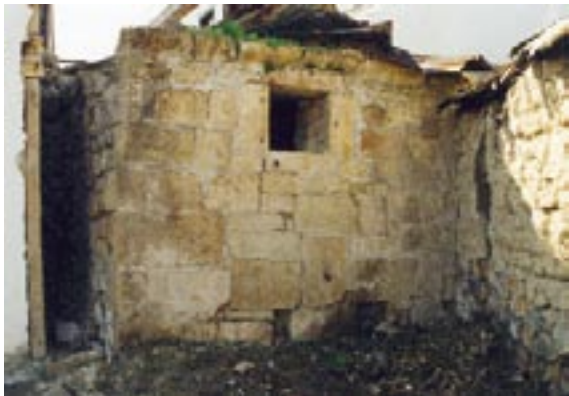
363. Resim: Dağ Salı Sokağı Çeşmesi, kuzey cephe
