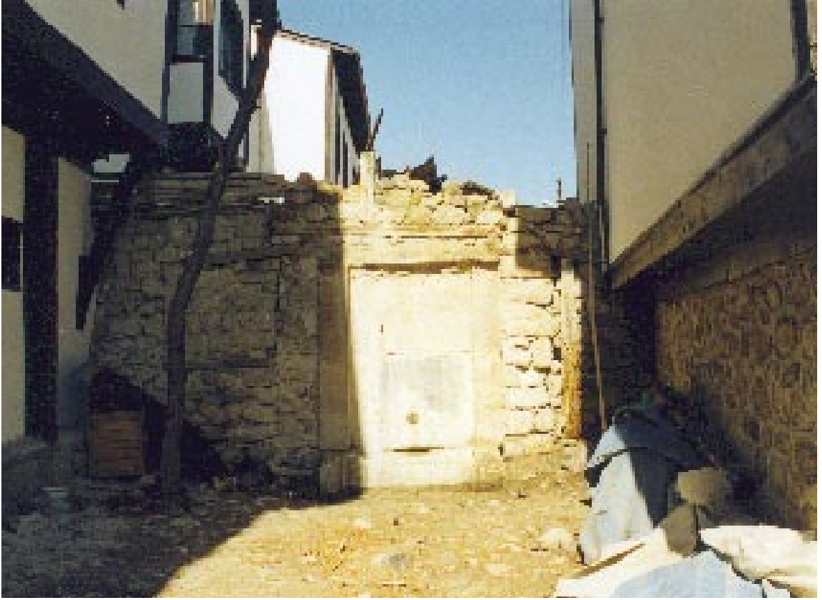
365. Resim: Dağ Salı Sokağı Çeşmesi, güney cephe
