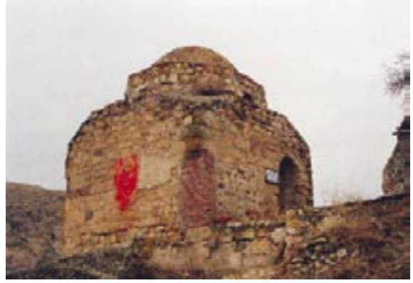
219. Resim: Boğazkesen Türbesi, güney ve doğu cepheler
