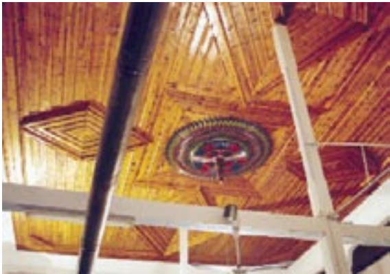
37. Resim: Alâeddin Camii, ahşap tavan kaplaması
