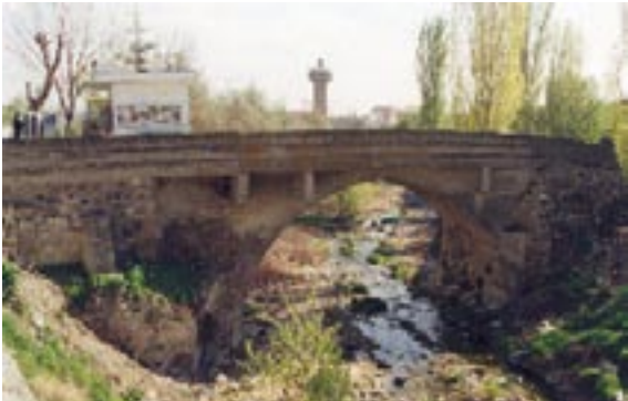
346. Resim: Hacılar Köprüsü, membâ cephesi
