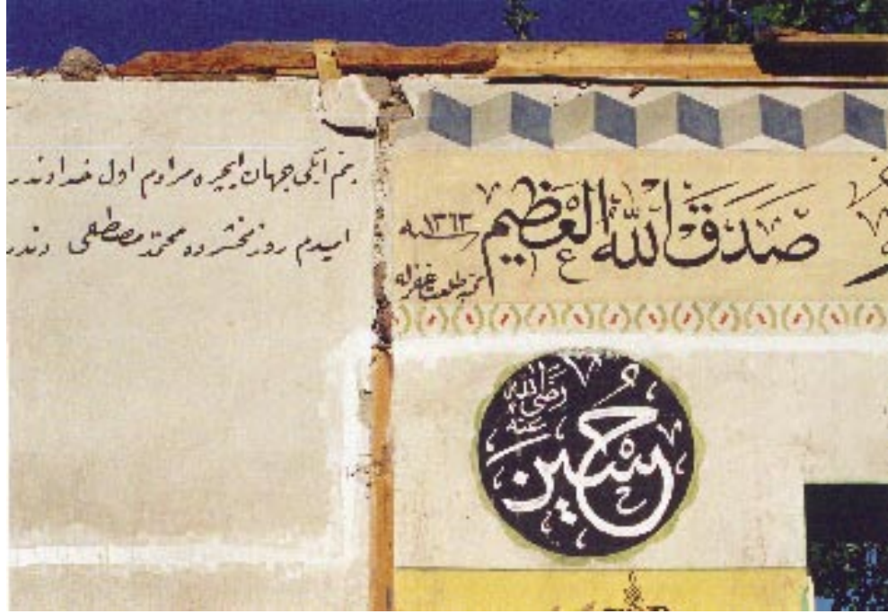
208. Resim: Üreğil Köyü Camii, ayet’el kürsi kuşağının sonundaki usta kitabesi
