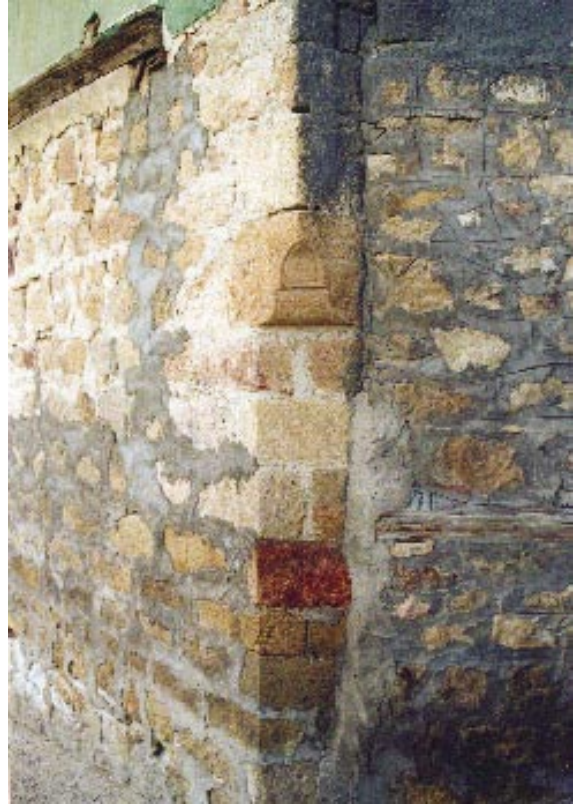
98. Resim: Karcıkaya Camii, zemin platformunun güneydoğudaki pahlı köşesi
