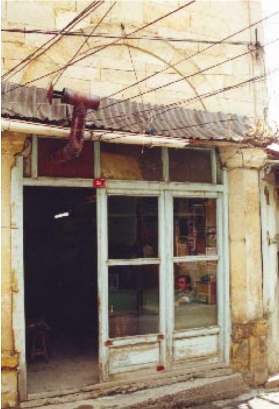
76. Resim: İncili Camii, güneybatı köşedeki dükkan
