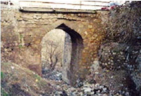
348. Resim: Karcıkaya Köprüsü, membâ cephesi
