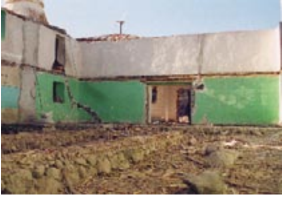
209. Resim: Üreğil Köyü Camii, harimin kuzey görünüşü
