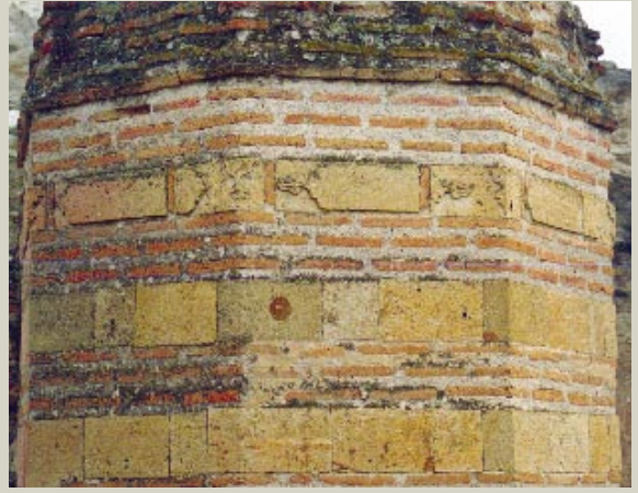
46. Resim: Eski Derbendçik Camii, minare kaidesinden görünüş
