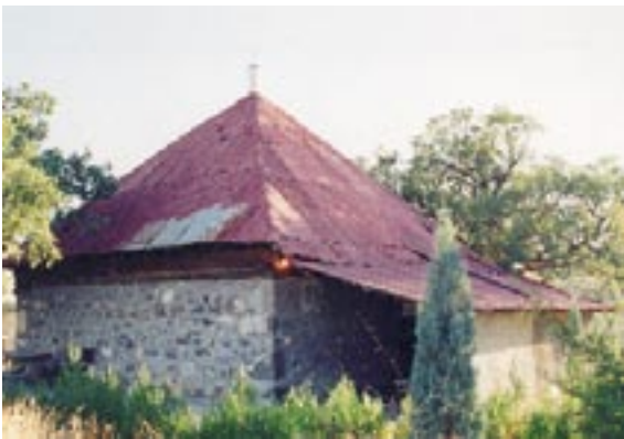
252. Resim: Kabaca Köyü Kaygusuz Abdal Türbesi, kuzeydoğudan genel görünüş
