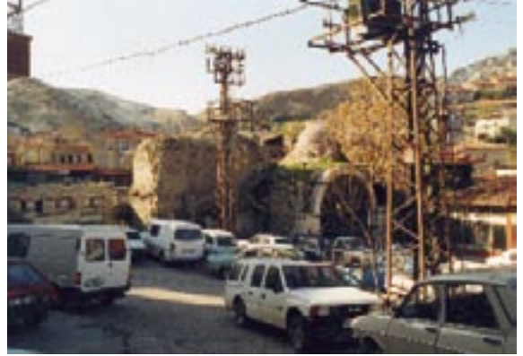
298. Resim: Suluhan, güneydoğudan görünüş
