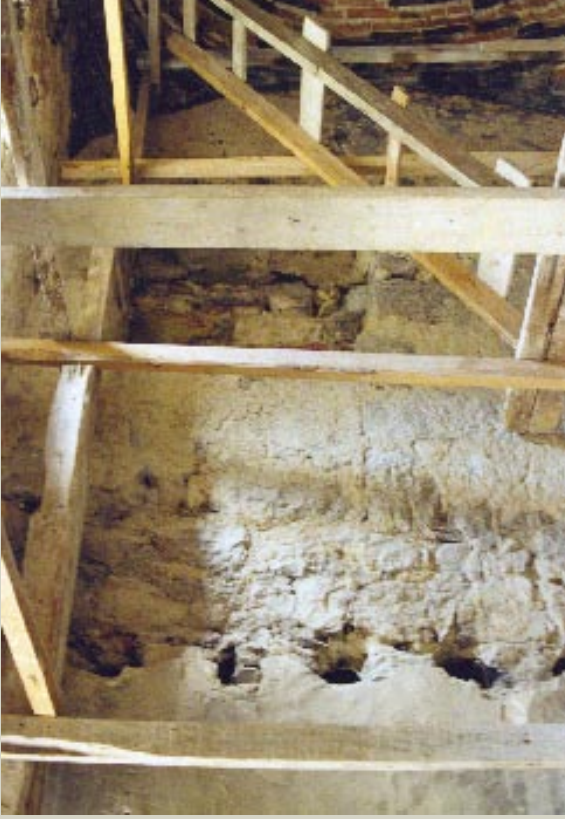
308. Resim: Suluhan, zemin ve birinci kat odaları arasındaki ahşap kırışlemeli döşemeye ait izleri
