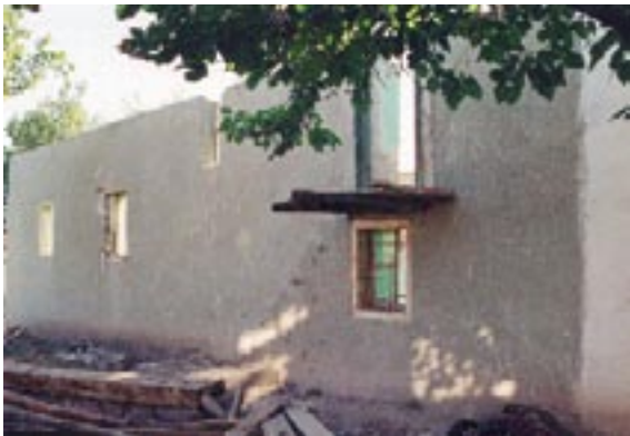
203. Resim: Üreğil Köyü Camii, doğu cephe
