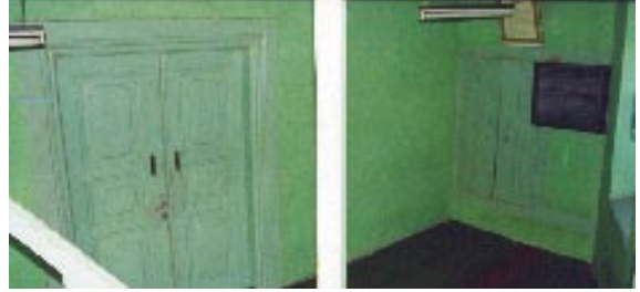
83. Resim: İncili Camii, harime giriş kapısı
