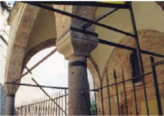
113. Resim: Kurşunlu Camii, son cemaat mahalli sütun ve demir aksamları
