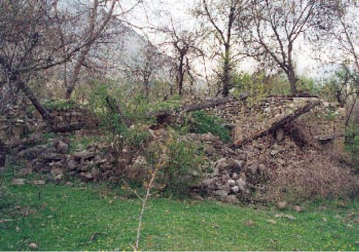
200. Resim: Dudaş Köyü Eski Camii, kuzeydoğudan genel görünüş
