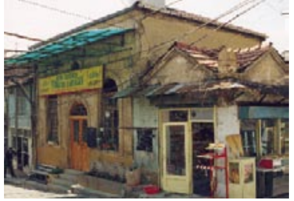
130. Resim: Tabakhane Camii, kuzeybatıdan cephe
