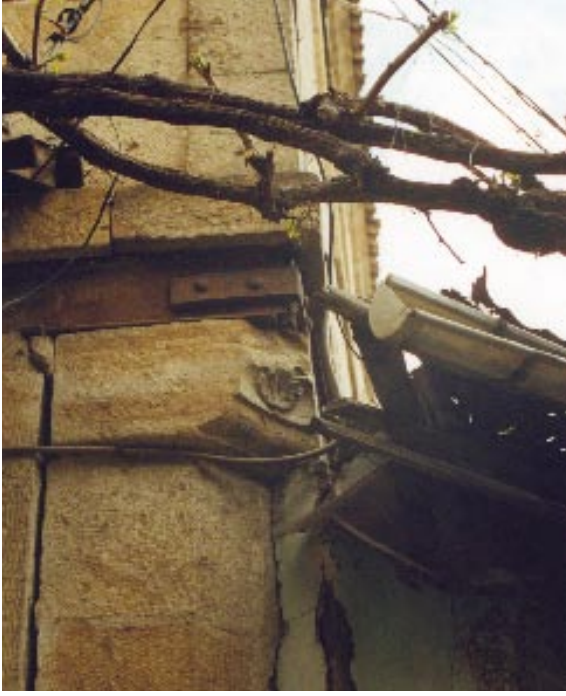
77. Resim: İncili Camii, güneybatı köşeden cephe detayı
