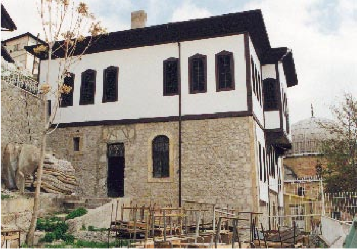
267. Resim: Taş Mektep, batı cephe
