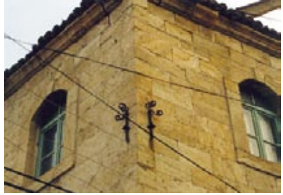
74. Resim: İncili Camii, kuzeydoğu köşeden cephe detayı
