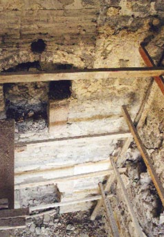
311. Resim: Suluhan, zemin ve birinci kat odalarının bacalı nişleri
