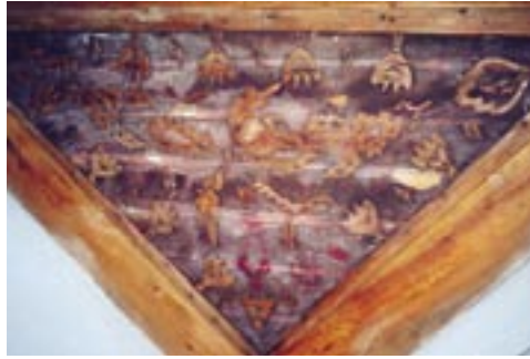
65. Resim: İmaret Camii, güneybatı ahşap tavan köşeliği
