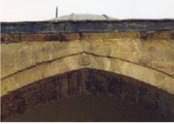
112. Resim: Kurşunlu Camii, son cemaat mahalli revağının doğu cephesindeki sivri kemerinden detay
