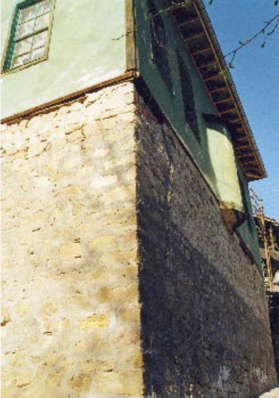
97. Resim: Karcıkaya Camii, güney cephe ve mihrap çıkması
