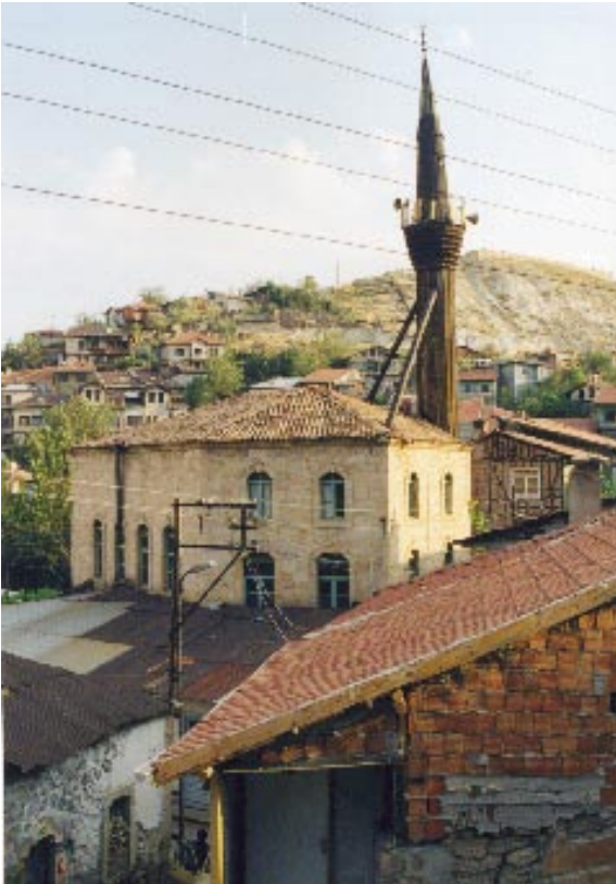
71. Resim: İncili Camii, kuzeydoğudan genel görünüş
