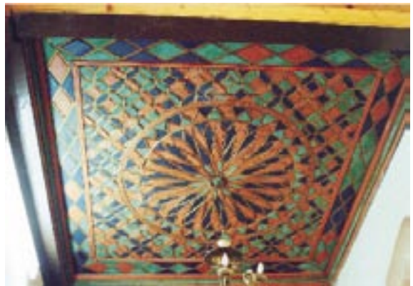
126. Resim: Kurşunlu Camii, mahfil döşemesi altında taklit künde-kari tekniğinde yapılmış ahşap tavan kaplaması
