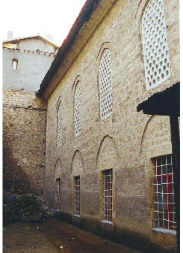
27. Resim: Alâeddin Camii, doğu cephe
