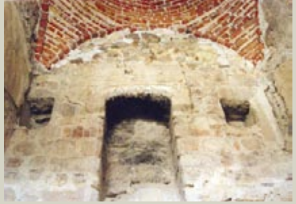
309. Resim: Suluhan, restorasyon sonrası birinci kat odaları ve tuğla örgülü pendentifler
