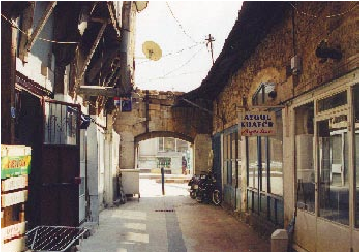
278. Resim: Hanlarönü Arastası, güney girişi ve arasta koridoru
