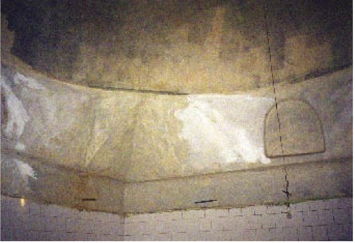
343. Resim: Rüstem Paşa Hamamı, merkezi mekânın kubbe geçişindeki prizmatik üçgenler
