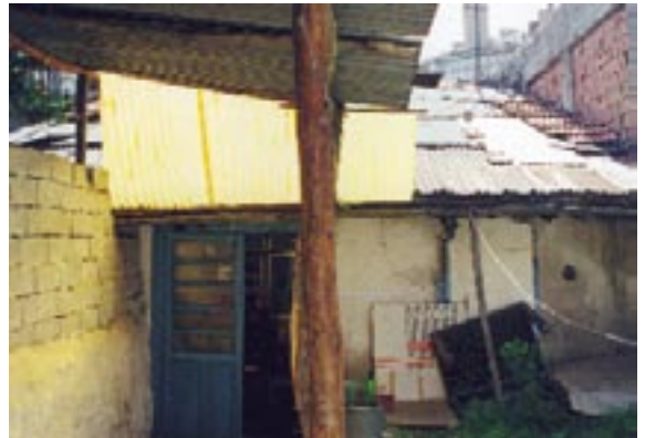
339. Resim: Rüstem Paşa Hamamı, erkeler kısmına giriş
