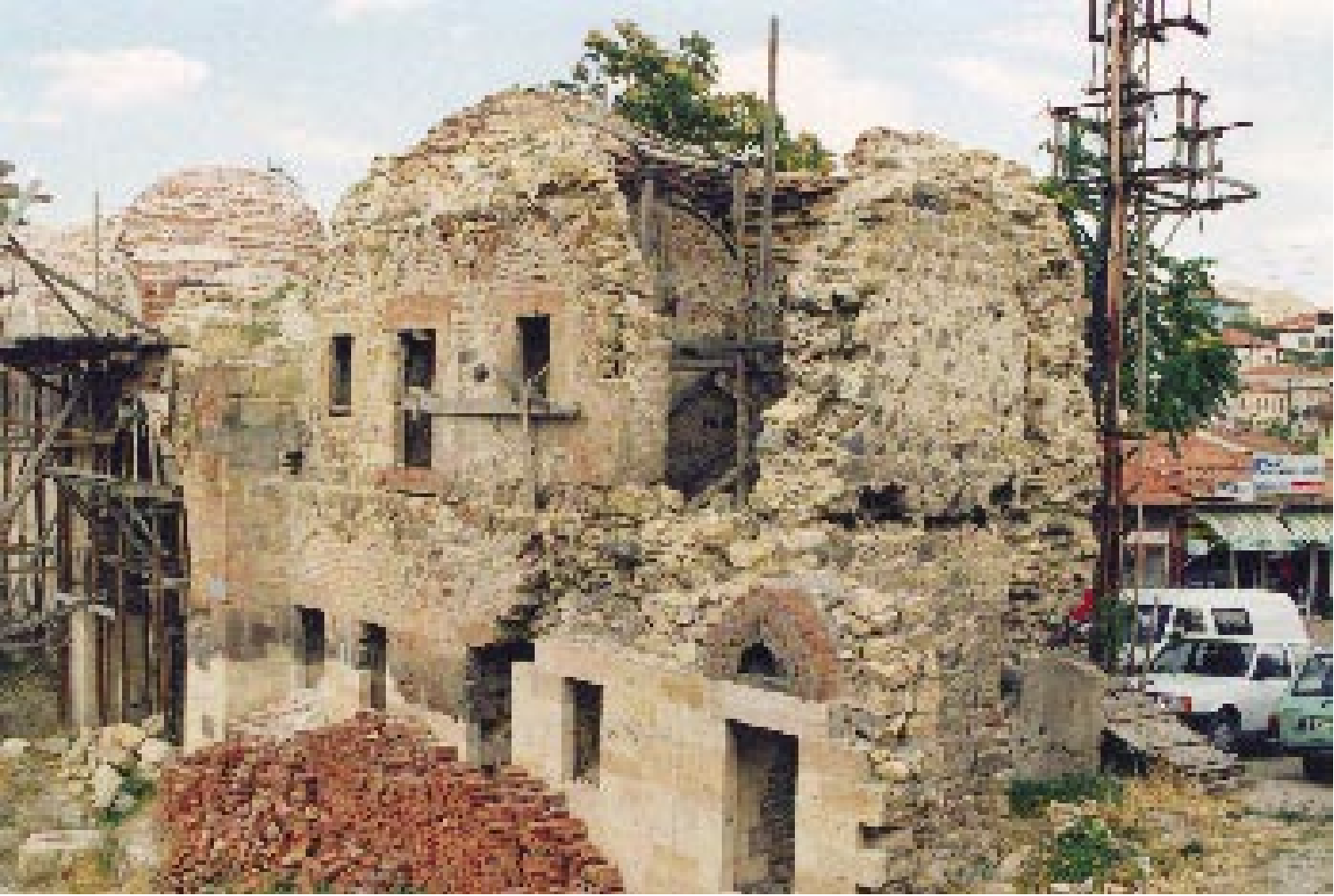
305. Resim: Suluhan, doğu kanadın yıkık olan güney köşesi
