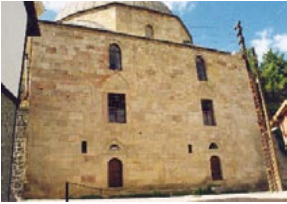
108. Resim: Kırşınlu Camii, güney cephe
