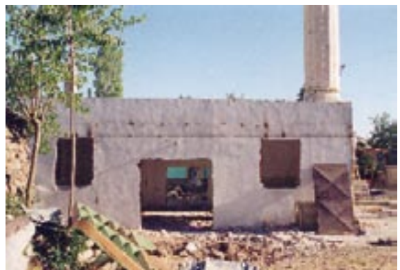
204. Resim: Üreğil Köyü Camii, kuzey cephe
