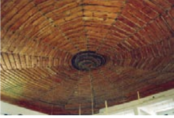
63. Resim: İmaret Camii, ahşap tavan kaplaması
