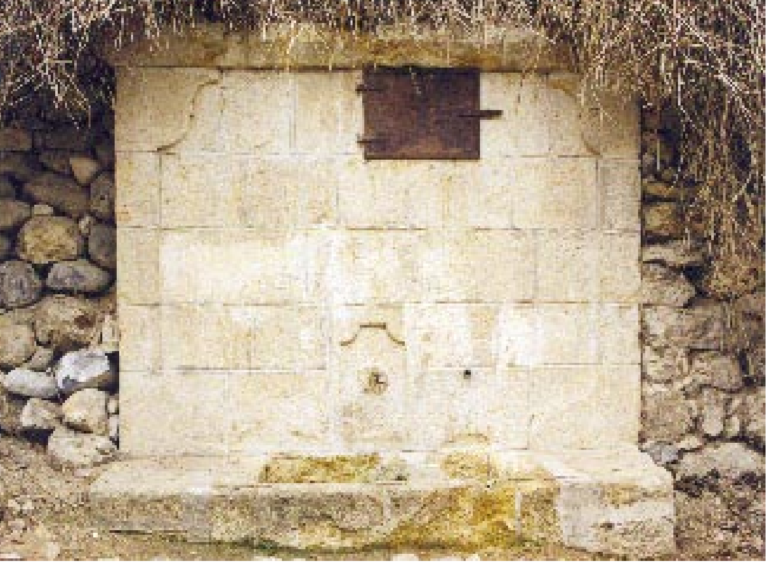
352. Resim: Arkbaşı Sokağı Çeşmesi, cepheden görünüş
