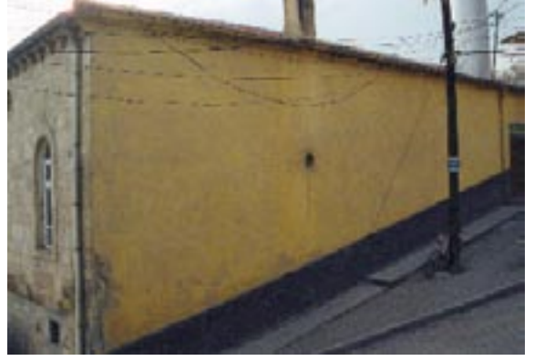
146. Resim: Yeni Camii, doğu cephe
