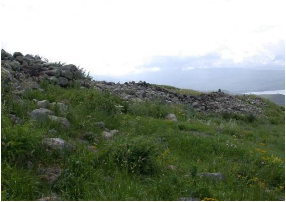
Resim-25 Senger Kalesi Yıkılmış Duvar Örgüsü
