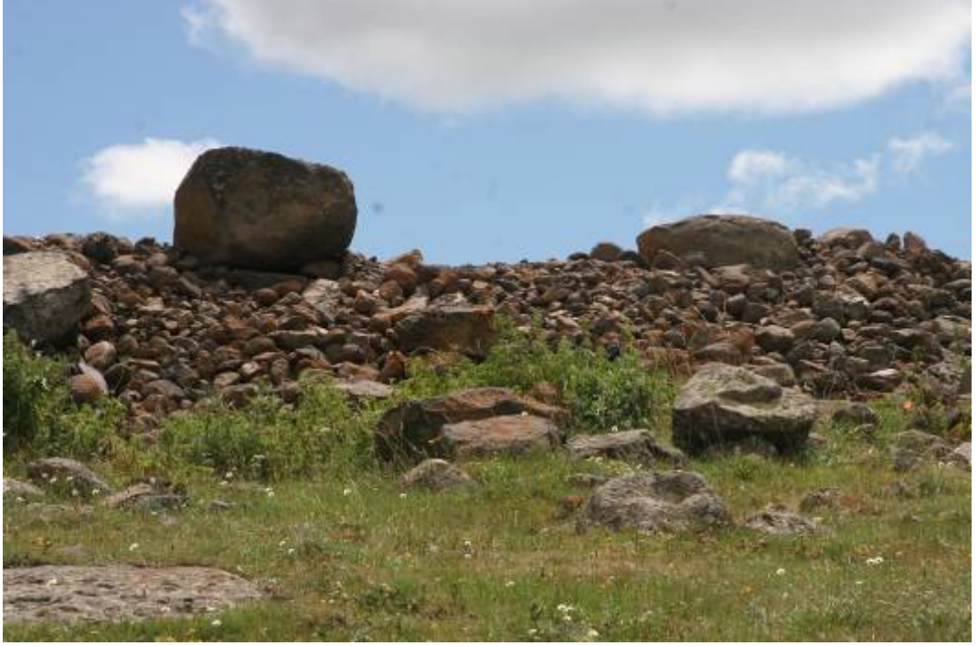
Resim-37 Başköy Kalesi Yıkılmış Duvar Örgüsü
