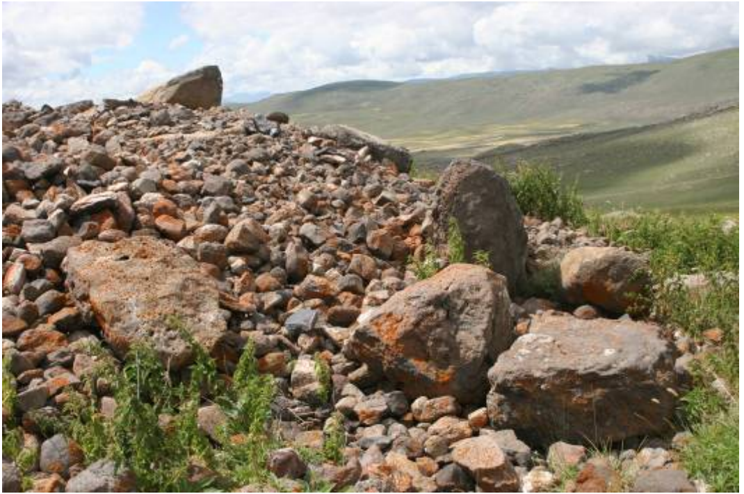
Resim-36 Başköy Kalesi Yıkılmış Duvar Örgüsü
