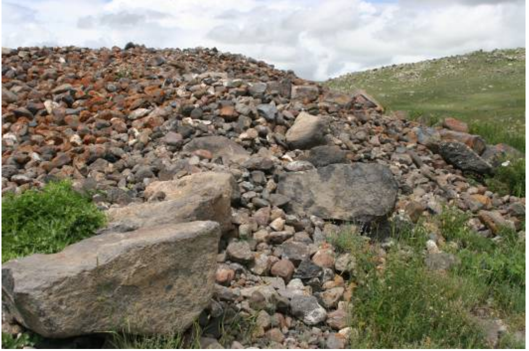
Resim-35 Başköy Kalesi Yıkılmış Duvar Örgüsü
