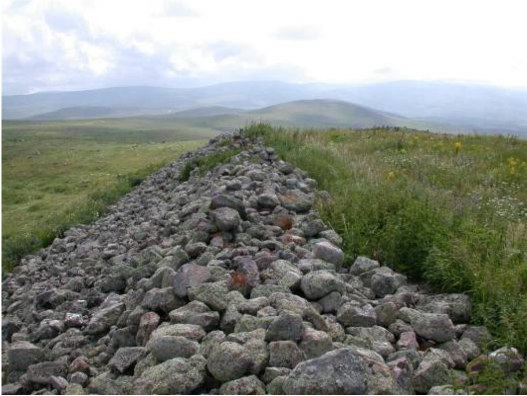
Resim-26 Senger Kalesi Yıkılmış Duvar Örgüsü
