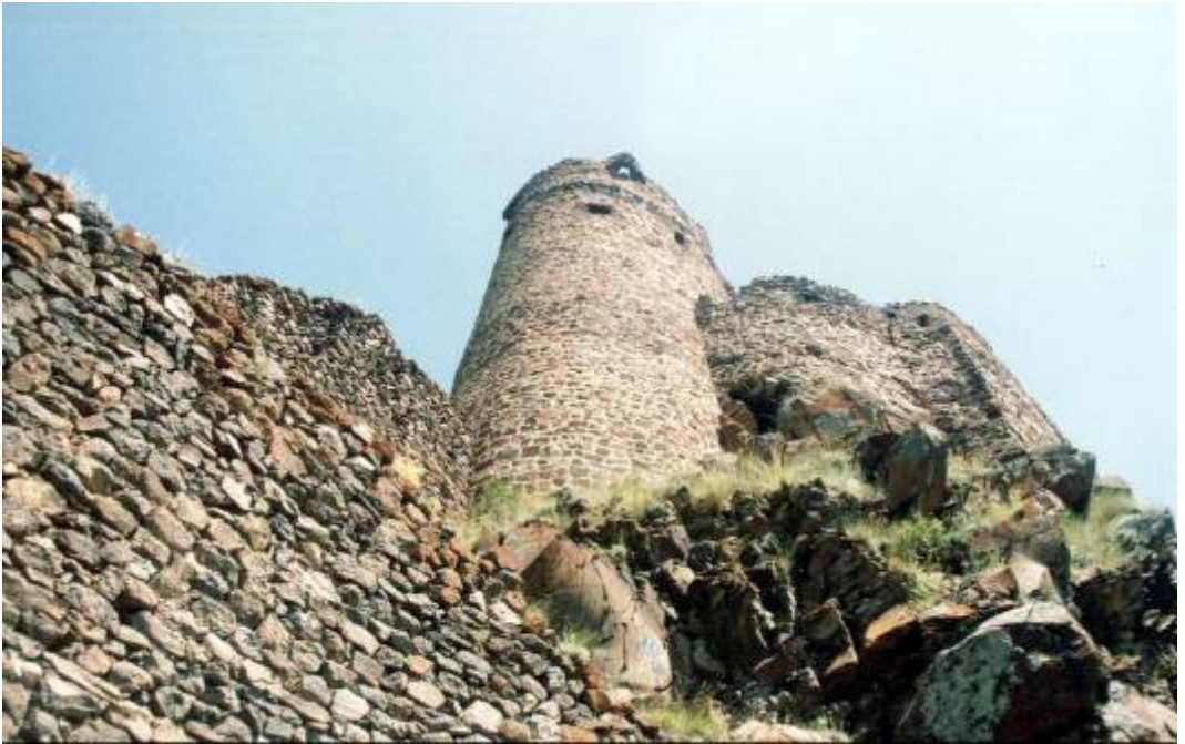
Resim-28 Şeytan Kalesi Duvar Örgüsü
