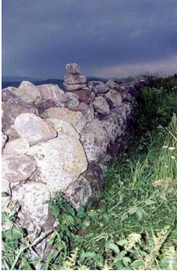
Resim-24 Senger Kalesi Duvar Örgüsü
