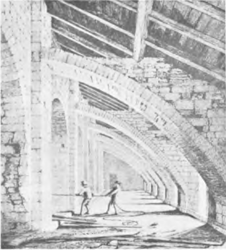
Resim 10: Durham katedralinin uçan payandaları, 1843'te yayınlanmış bir gravür. R. W. Billings, Architectural Illustrations of the Cathedral of Durham , Londra, 1843.
