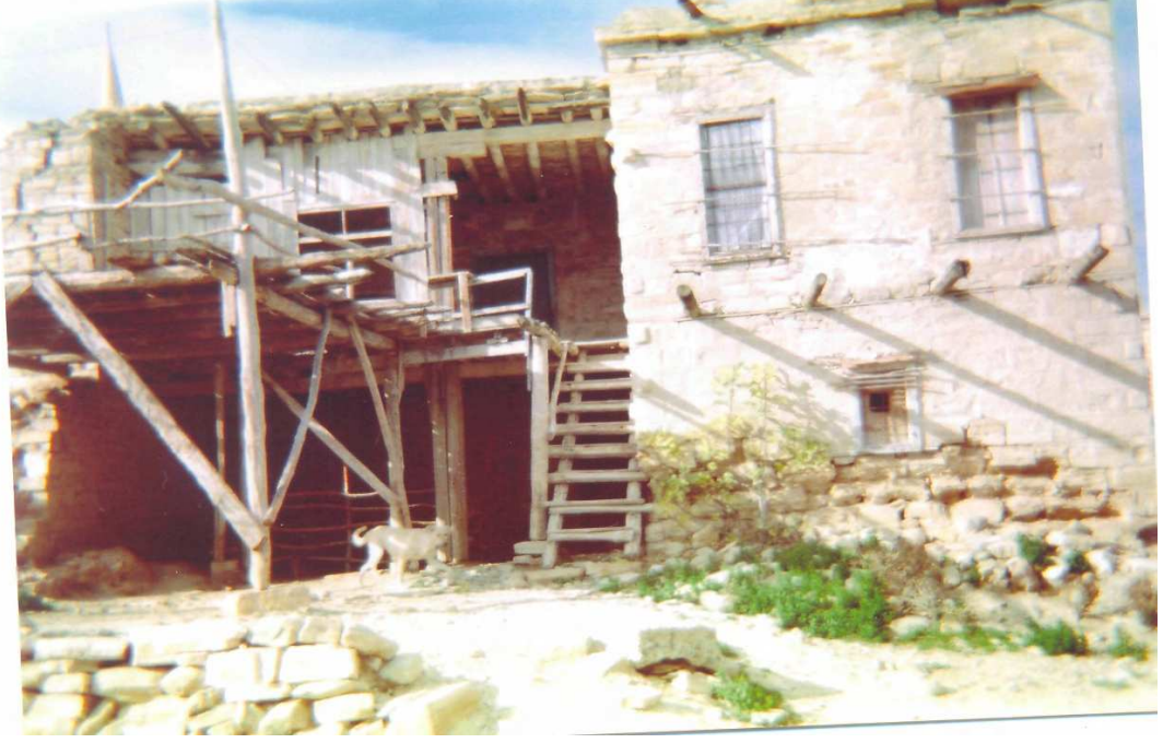
15: Karaisalı'da eski bir köy evinden görünüş
