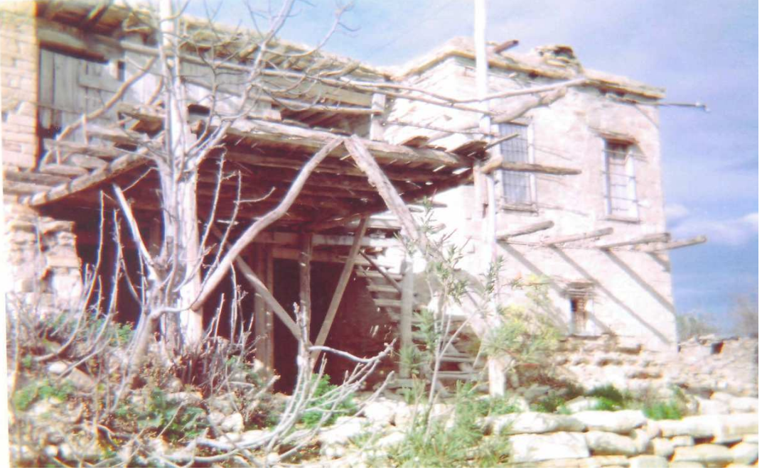
16: Karaisalı'da eski bir köy evinden görünüş
