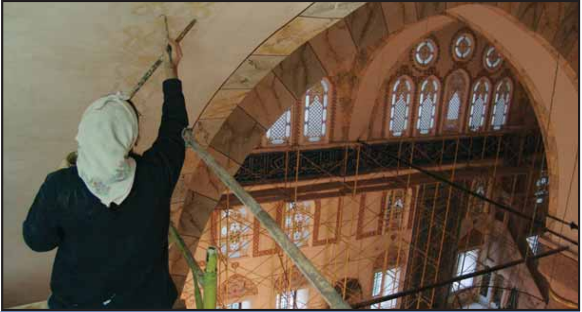
Piyalepaşa Camii restorasyonu bir yıl boyunca devam etti.
