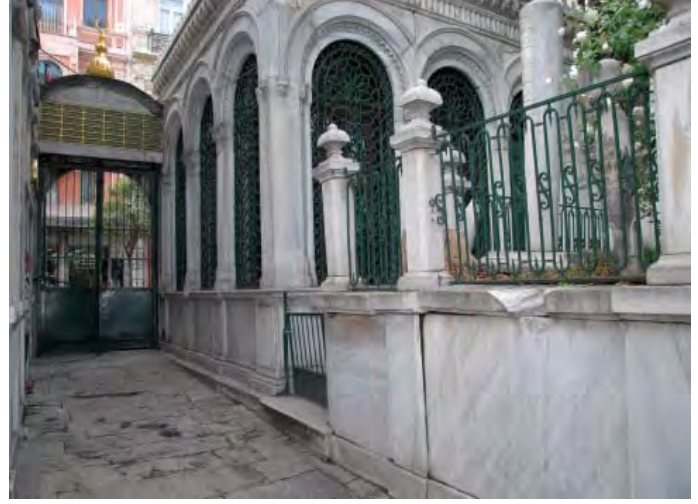
Galata Mevlevihanesi kapı girişi içten görünüm
