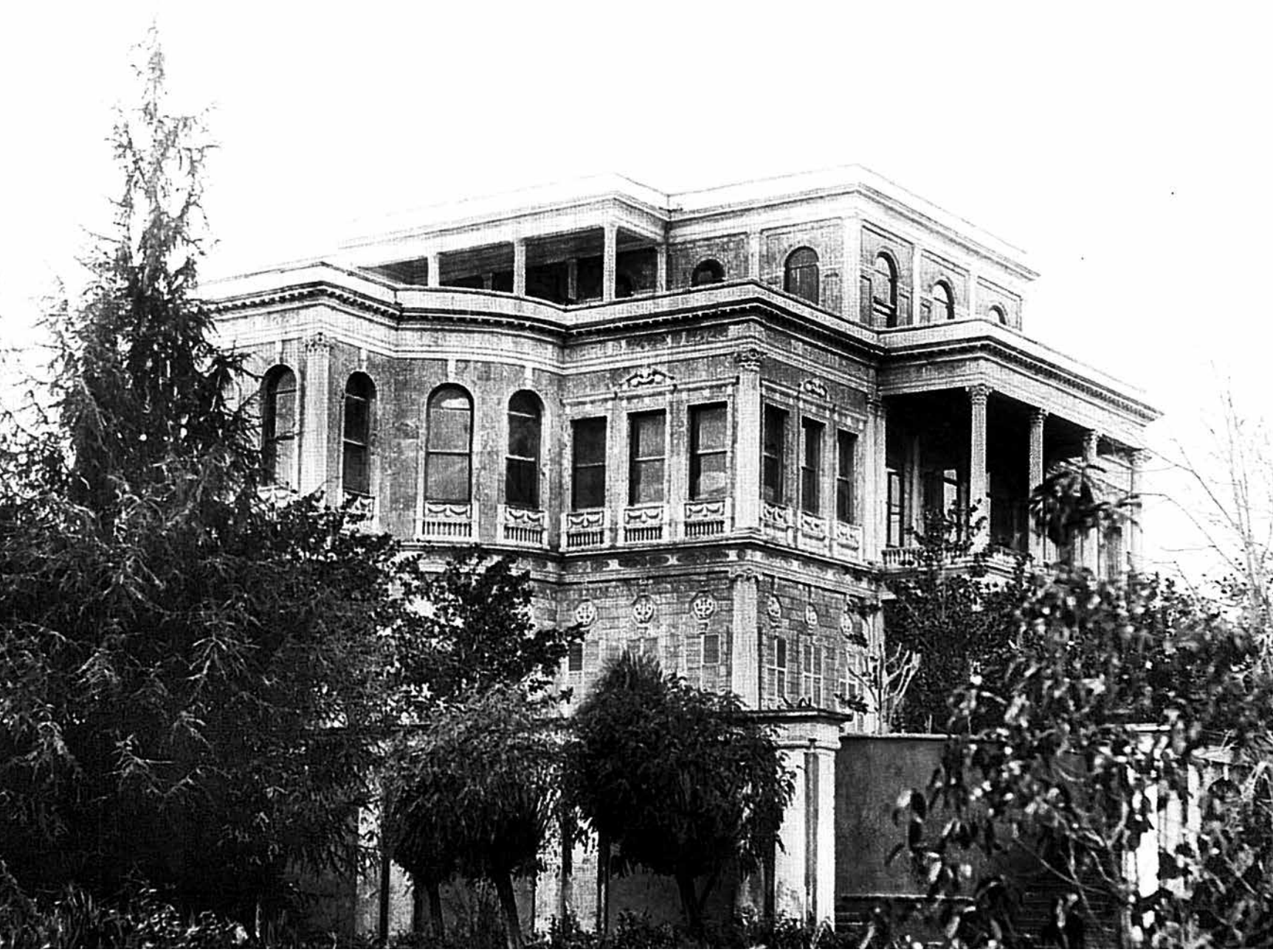
Beykoz Kasrı Hümayunu'nun yapımından sonraki denize bakan yan ve ön cephesinin görünümü. (Foto: B. Kargopoulou)
