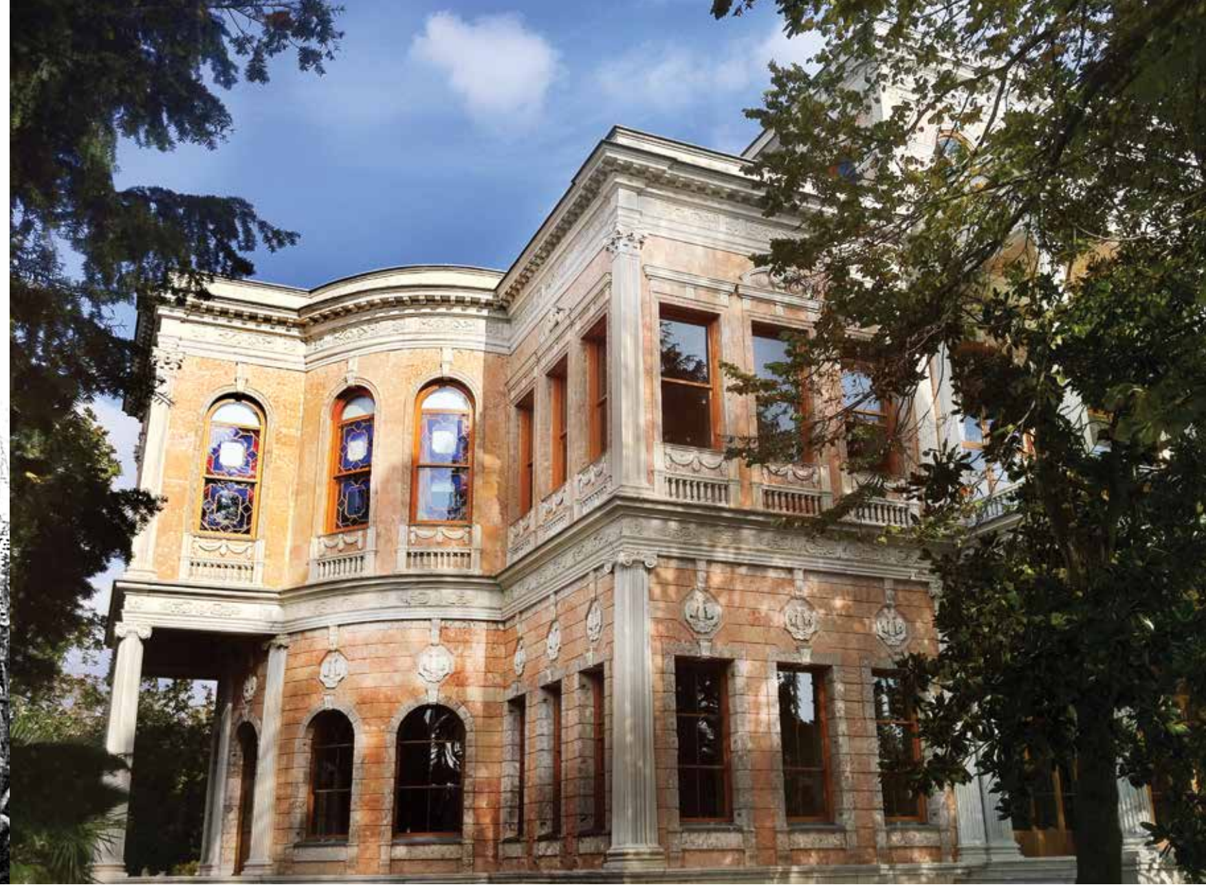
Beykoz Kasrı'nın restorasyon sonrası ön ve yan cephesi. Büyüyen ağaçlar kasrın ilk yapıldığı zamanki görüntüsünü engellemiş. (Foto: Süleyman Kızıltoprak)
