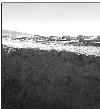
گودبرداری زمین منطقه برای پارک سازی
