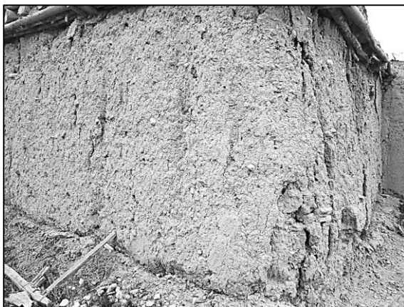
بقایای دیوار چینه‌ای قلعه قاسم‌خان با عمری نزدیک به ۳۰۰ سال (تصویر از داخل باغ آقای احمد قاسم‌خانی تهیه شده است)
