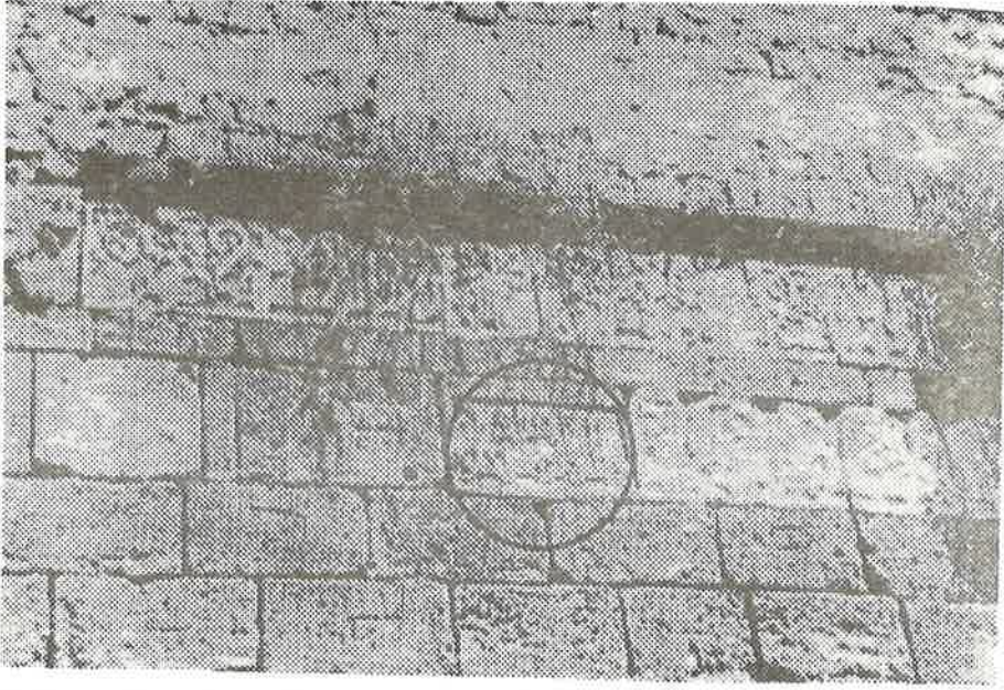
Resim 52, Dicle Köprüsü (Silvan Köprüsü-On Kapılı Köprü) / Diyarbakır
