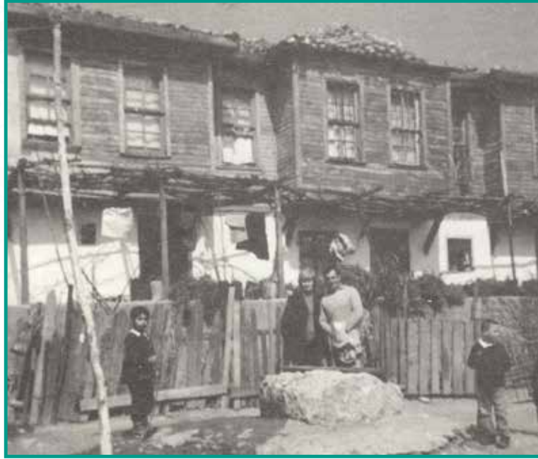
Fotoğraf: Eski Arnavutköy'de Sivil Mimarlık Örneği
