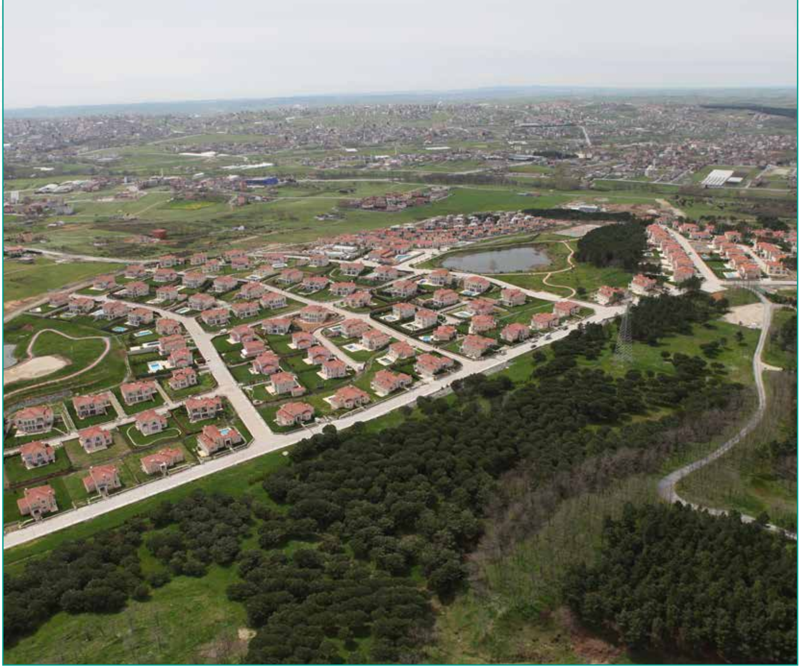
Fotoğraf: Arnavutköy'de Yeni Yapılaşma
