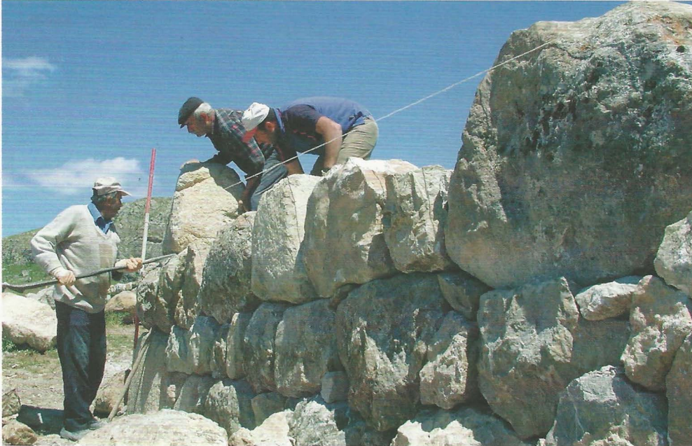
46. Taş kaidenin inşası sabır ve tecrübe işi
