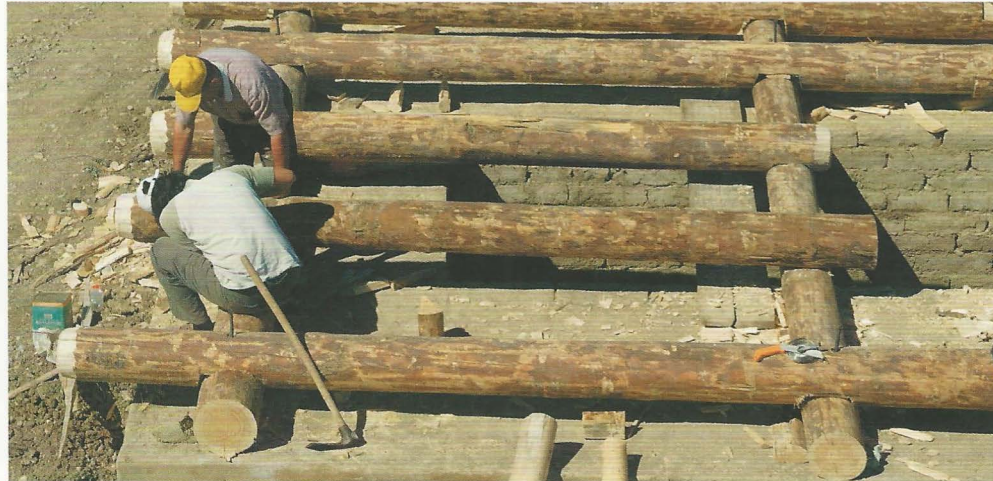
90. Kuzey kulenin alt yatay iskeletinin hazırlanması
