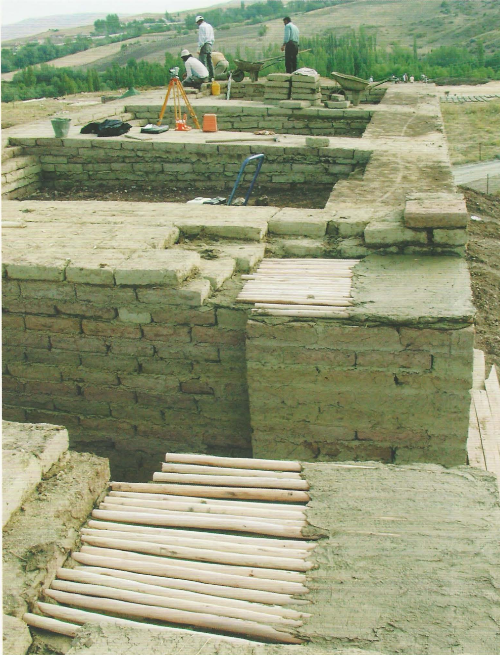
63. Kuzey kuleye girişin üstü kapatılıyor: Tomrukların altına yuvarlak ağaçlardan yatak hazırlandı
