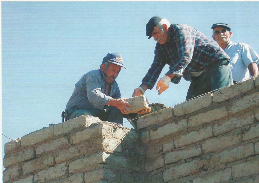
53. Tuğla duvar örgüsü. Mala, şakül ve su ibriği gereken aletler
