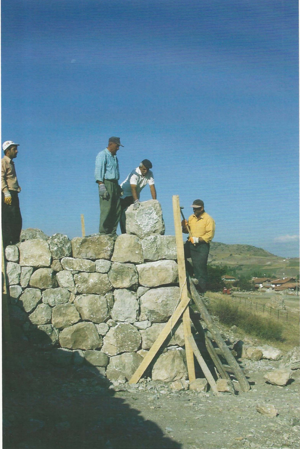
41. Kuzey kulenin taş kaidе kesiminin inşası
