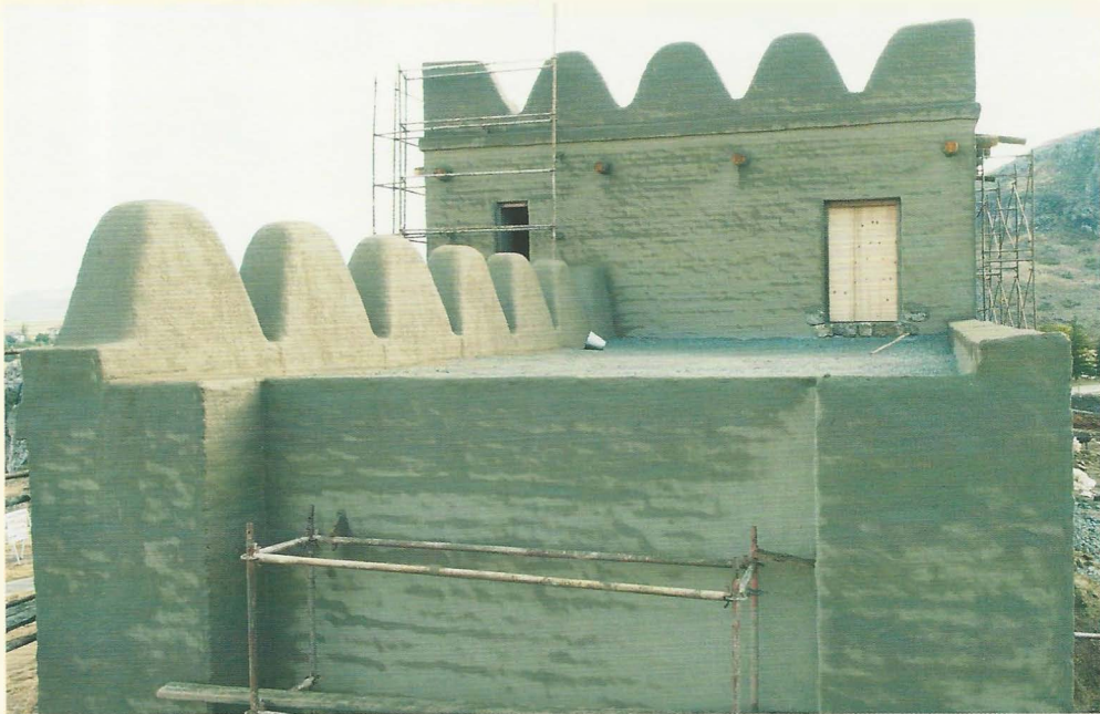
121. Tuğlaların arasındaki harçın düz tuğla yüzeylerine göre daha fazla rutubet tuttuğu sıva üzerinden de görülüyor
