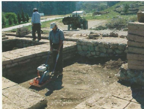
62. Sur sandıkları toprak ile dolduruldu
