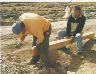
157. Kuzey kuledeki giriş kapısı için taş yuvalar içinde dönecek söveler biçimlendirildi
