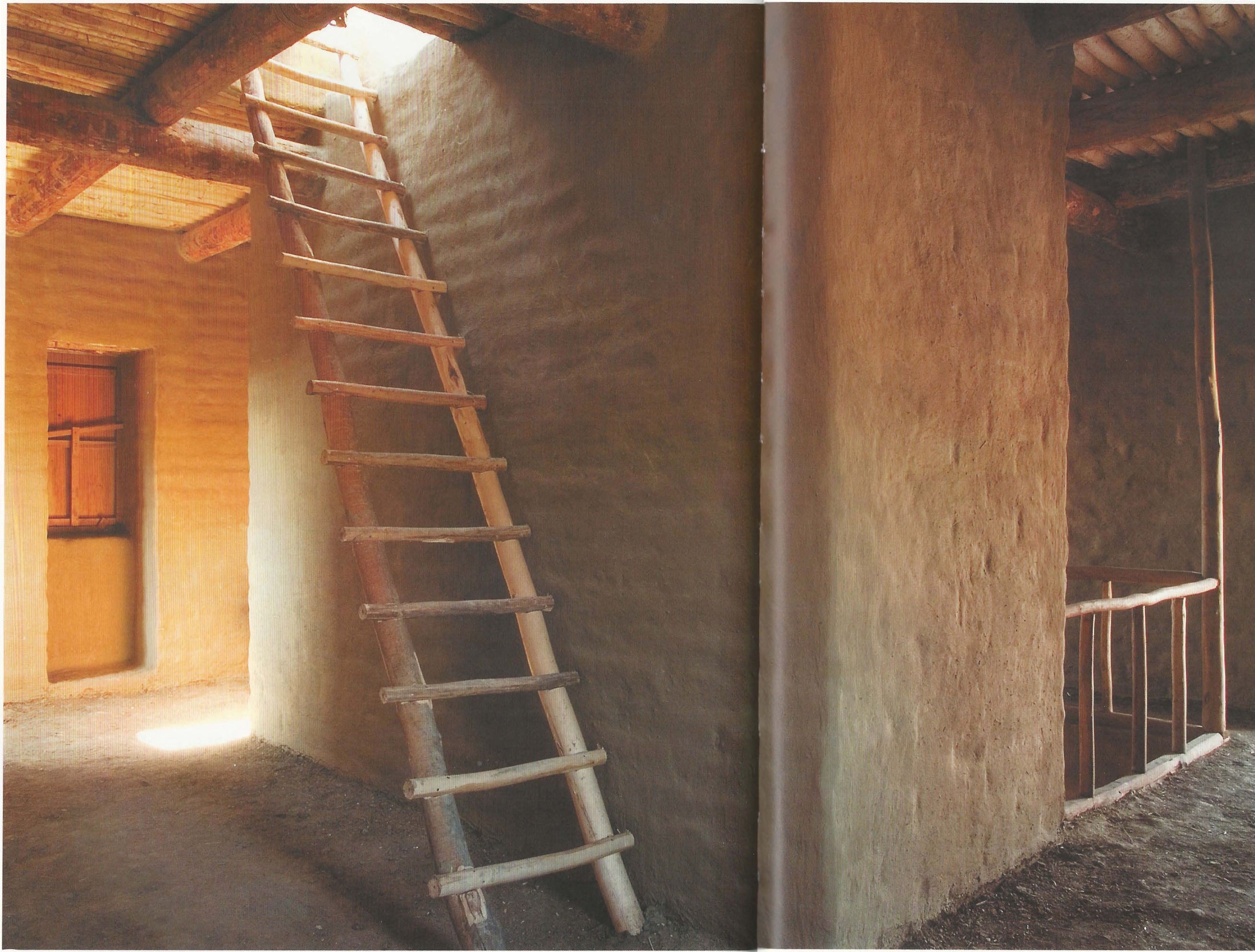
176. Kulenin içindeki orta duvar iç mekana hakim bir konumda
