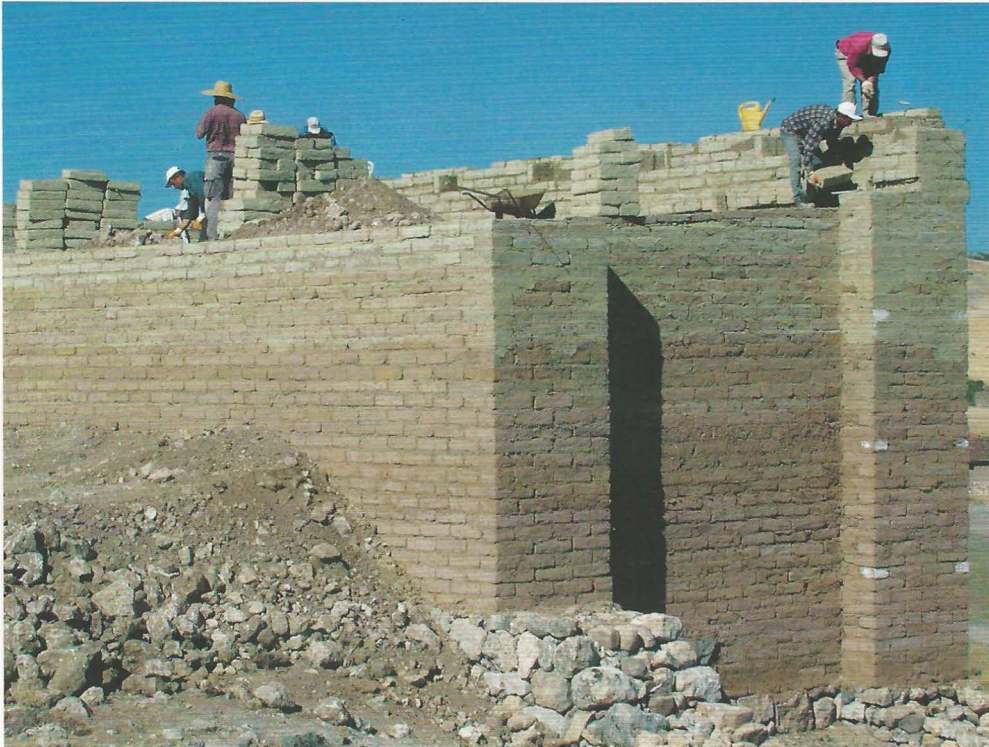
57. Farklı kerpiç toprağı cinsleri duvarda izlenebiliyor
