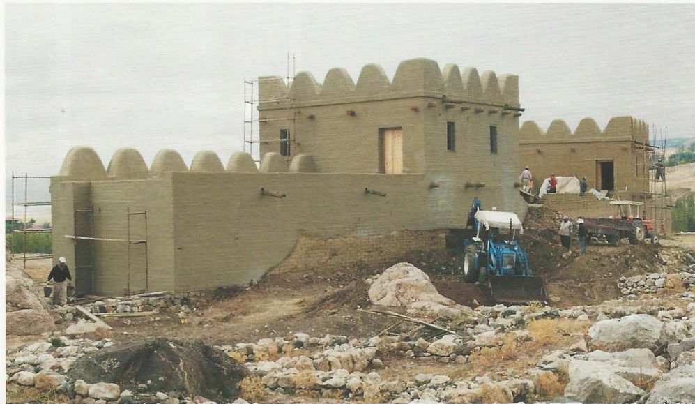
178. Son tuğlalar da yerine konduktan sonra toprak rampa kaldırıldı
