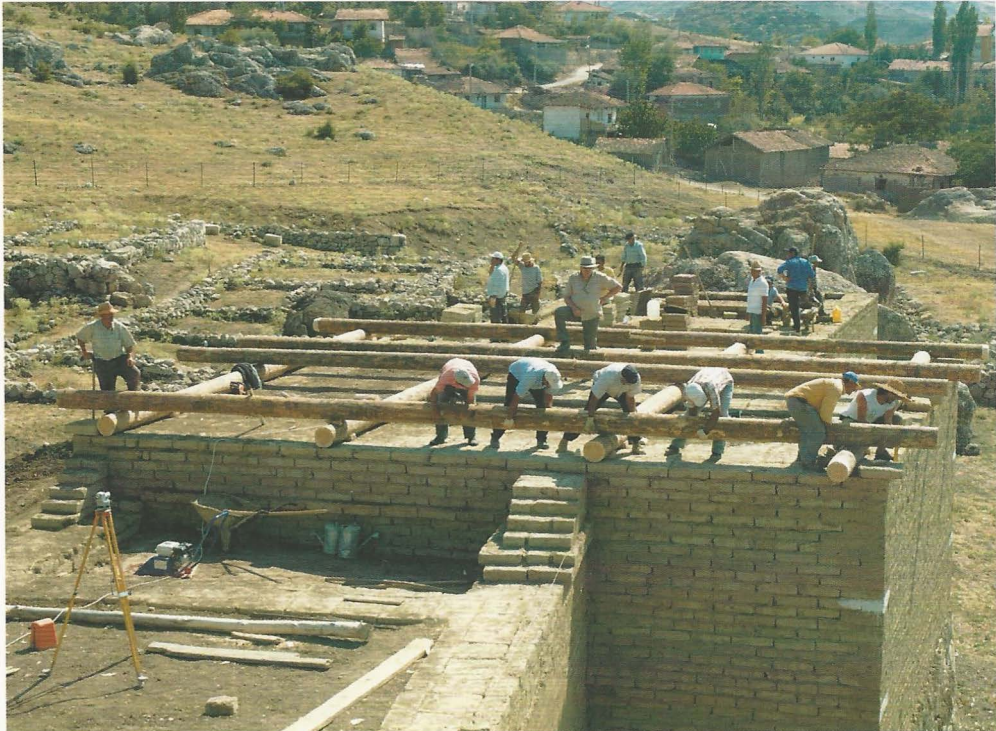
89. Güney kuleinin alt yatay iskeleti
