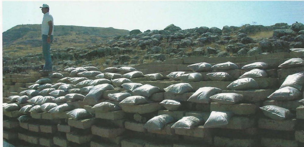
39. Tuğlalarla branda arasındaki mesafeyi korumak için saman dolmuş torbalar yerleştirildi
