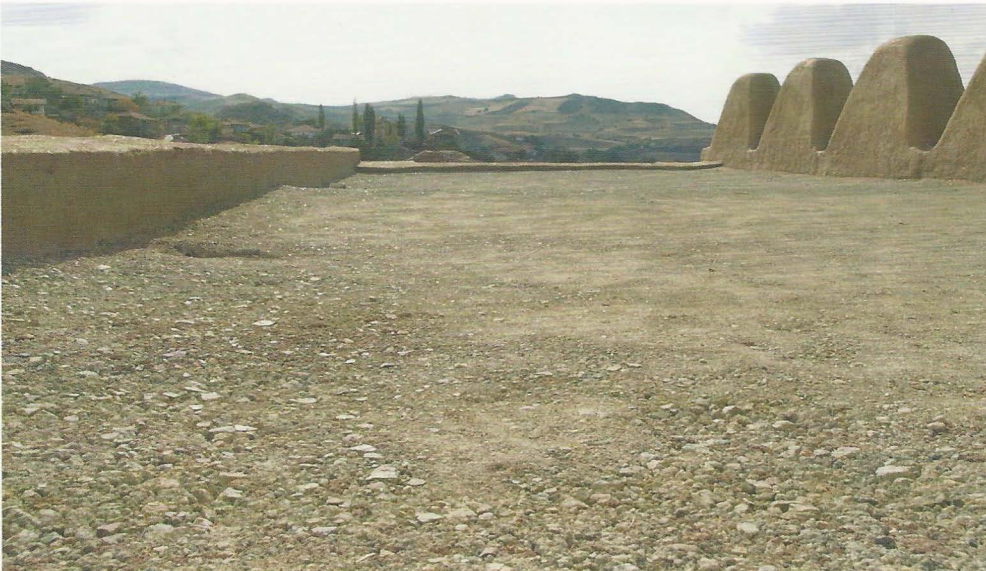
143. Güney sur bedeni üzerinde yağmur suyuna yön vermek için hazırlanmış eğimli alanlar
