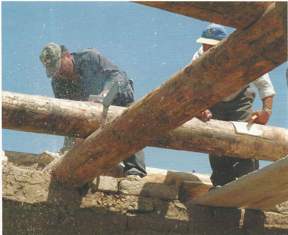
131. Üst yatay iskelette tomruklar, çatıyı da taşıyacakları için daha sık yerleştirildi
