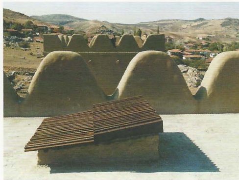
174. Kulenin çatısındaki açıklık kaydırmalı bir kapakile örtüldü
