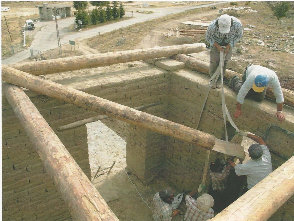
130. Bütün tomruklar yukarıya çıkarılmadan önce hazırlanıp birbirlerine uyduruldu
