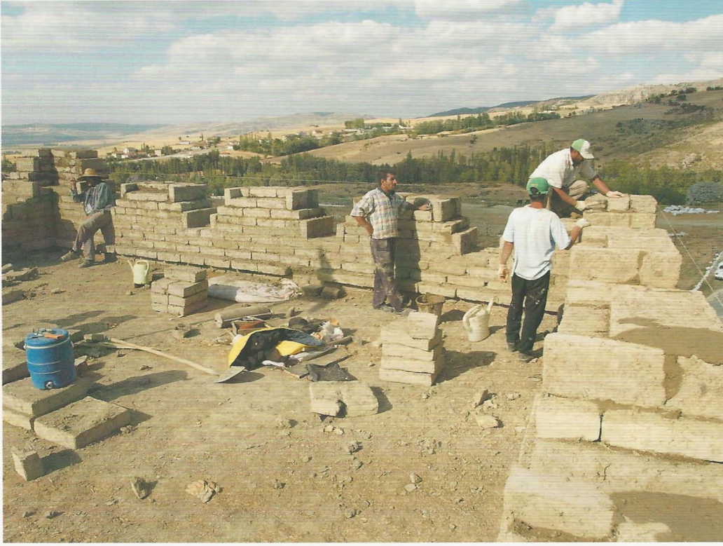
150 Kulelerin mazgal dişleri yapılıyor
