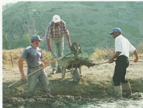
29. Kerpiç toprağı ve saman kuru halde kepçe ile karıştırıldı. Suyun ilavesinden sonra karıştırma işi el ve ayaklarla yapılmak zorunda
