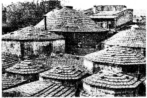
No: 79- Paşahamamı'nın tepeden görünüşü
