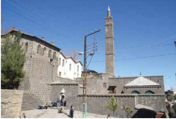
Foto: 7- Hz. Süleyman Camii'nin Batı Cephesi
