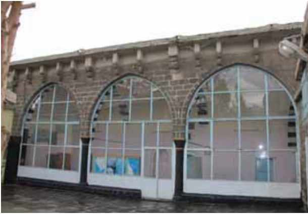
Foto: 30- Hoca Ahmed (Ayni Minare) Camii'nin Kuzey Cephesi
