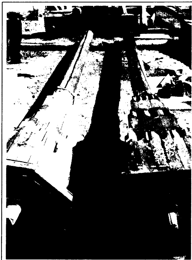
۶۹) شهرستان مراغه - مسجد ملامعزالدين ، اجزای تشکیل دهنده سرستون های حجمی شبستان اصلی مسجد (هنگام مرمت - ۱۳۸۳) (تصاویر از آقای هوشنگ بابایی)
