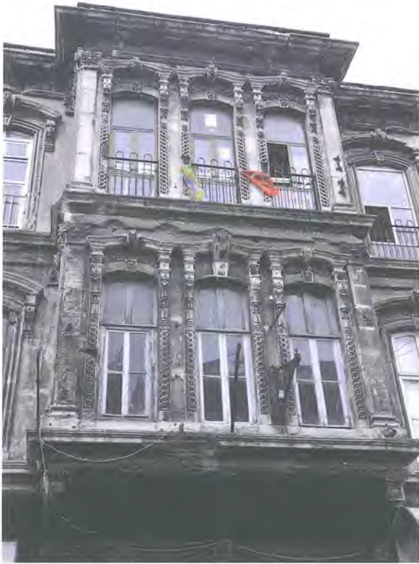
Şekil 4.27 Caferiye Han Cephe Görünüşü
