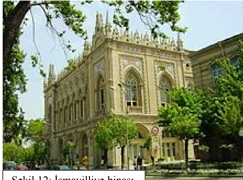
Şəkil 12; İsmayilliyyə binası
