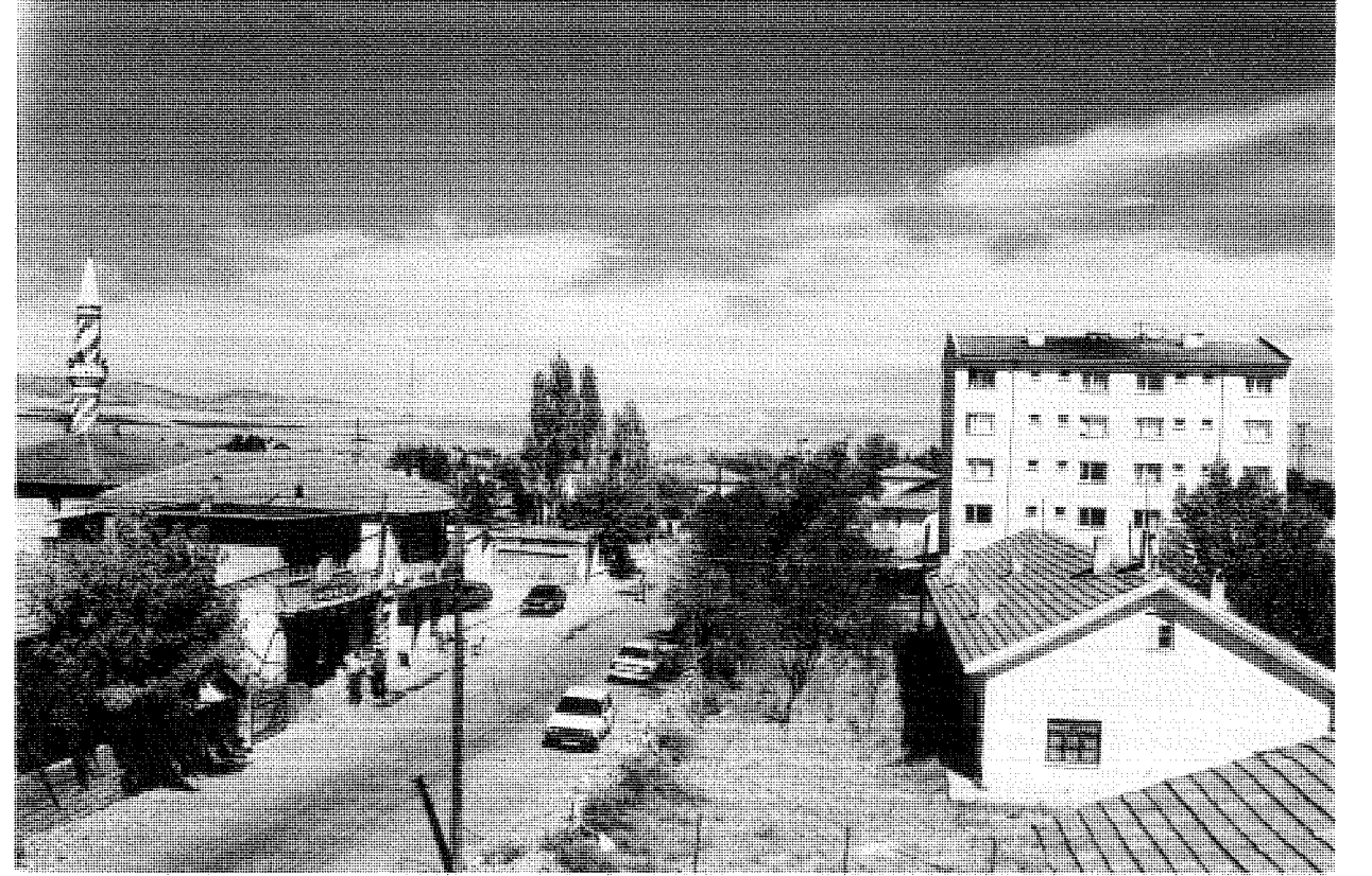
Yazihan İlçesi'nin genel görünüşü
