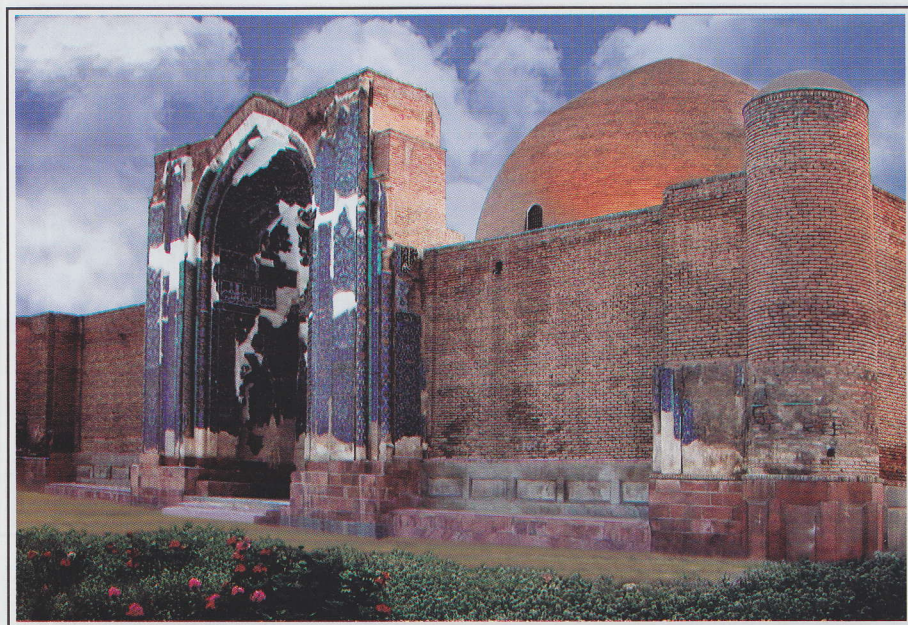
مسجد کبود ( فیروزه اسلام ) تبریز
