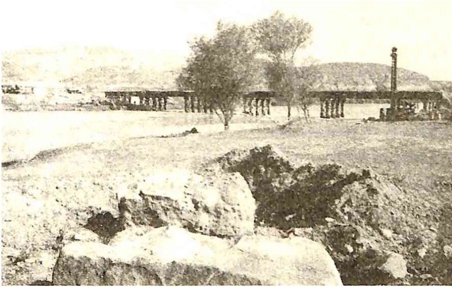
پل ارتباطی جدید طرح سد خداآفرین
