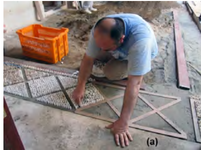
Fig. 25 a. Kaleiçi'nde bulunan bir konutta taşlık mozaği uygulaması, b. Uygulama sonrası bir görünüm.
