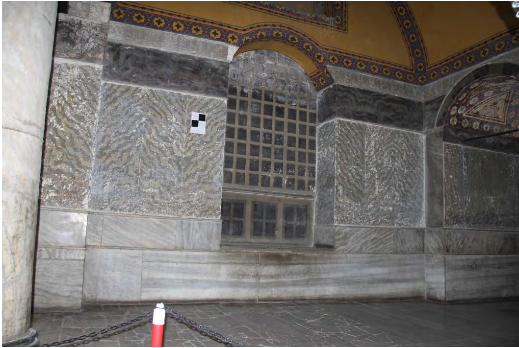
Fig. 10 Kuzey galeri doğu duvarı.
