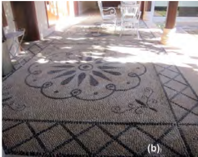
Fig. 25 a. Kaleiçi'nde bulunan bir konutta taşlık mozaği uygulaması, b. Uygulama sonrası bir görünüm.
