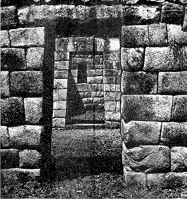
İnka duvarcılığının karakteristik özelliği bombeli taş blokların, aralarına harç konulmadan üst üste dizilmesidir.
