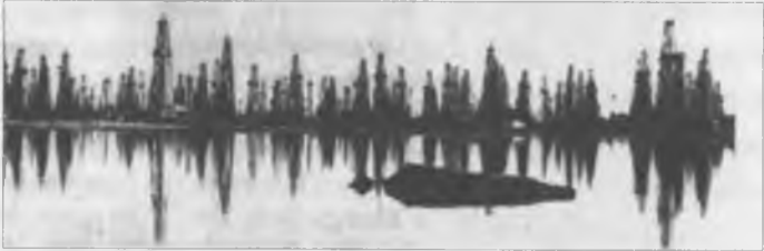
Hazar denizi kıyısında, Bakü'deki Sondaj kuleleri.
