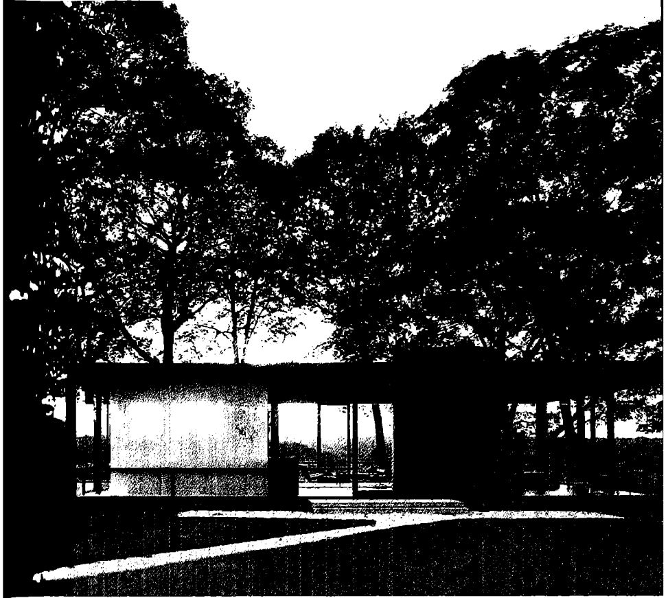
Zaman zaman karamsarlığa kapılacak, kendimizi mutsuz hissedeceğiz: Phillip Johnson, Camdan Ev, New Canaan, Connecticut, 1949
