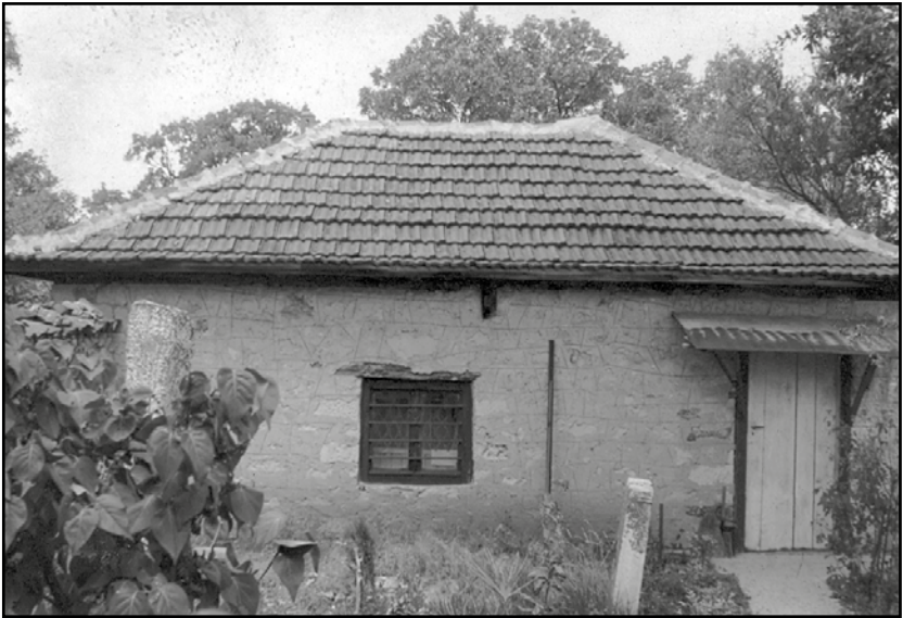
Hasan Baba Türbesi, Yeni Yapılmış Bina
