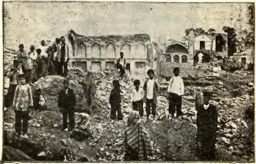
منظره خرابی سیل خرداد ۱۳۱۲ در قم
