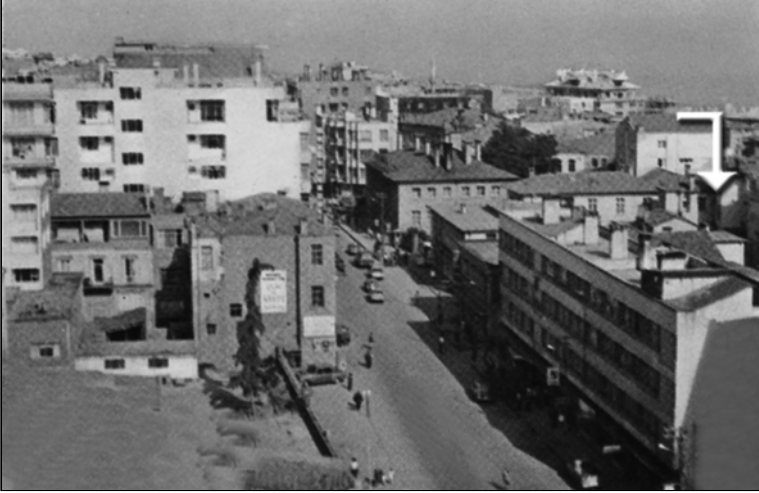
İpek Sinemasının yerine yapılmış olan eski TRT binası. (S. İskender arşivi)
