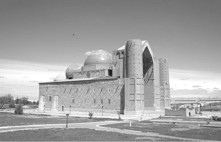
Xoca Əhməd Yəsəvi türbəsi təmirdən sonra
