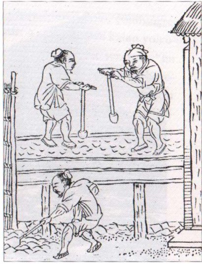
[6] Çin'in set inşasındaki toprak sıkıştırma yönteminin bir çizimi.
