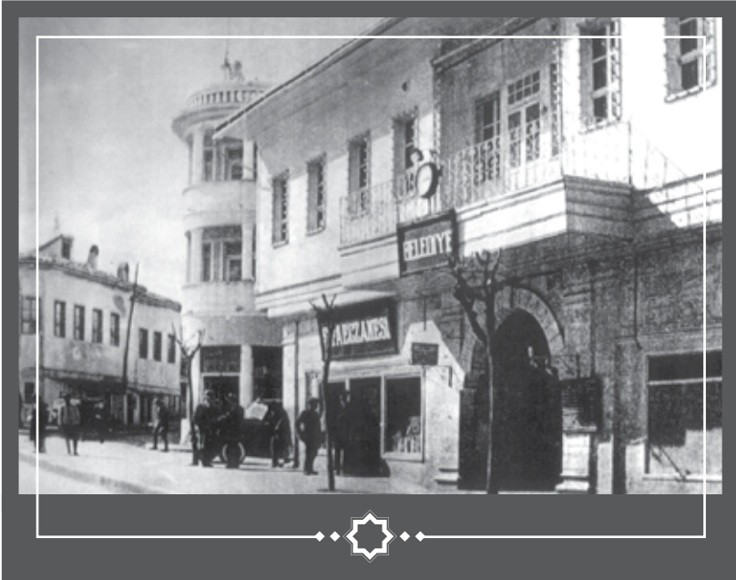
Atatürk Caddesinde Eski Belediye Binası ve alt katında Şifa Eczanesi
