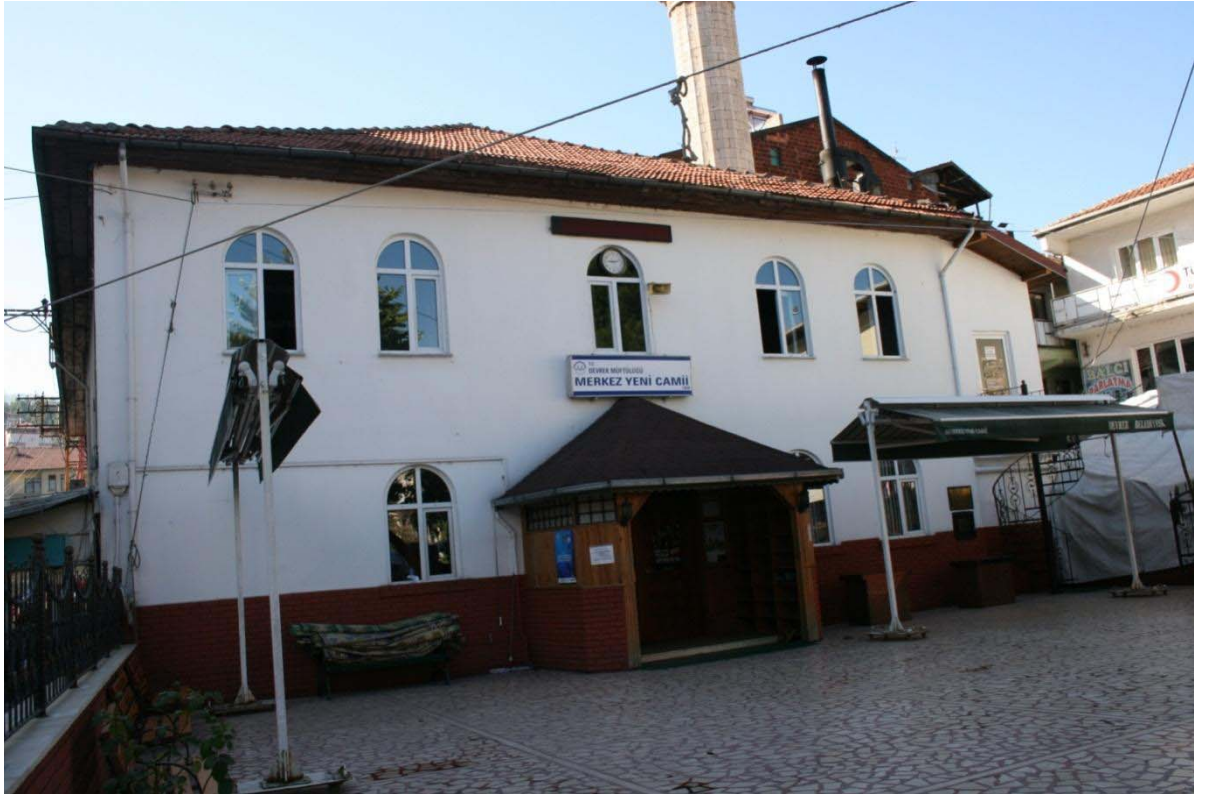
Resim 26: Devrek İlçesi Merkez Yeni Cami Kuzey Cephinin Görünümü
