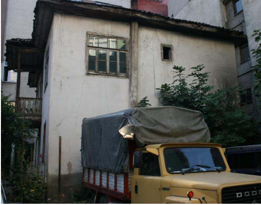
Resim 68: ZONGULDAK DEVREK İLÇESİ I NOLU KONUT, Eski Mahalle, Kocakuş Sokak, No: 8, 20. Yüzyıl, Batı Cephe
