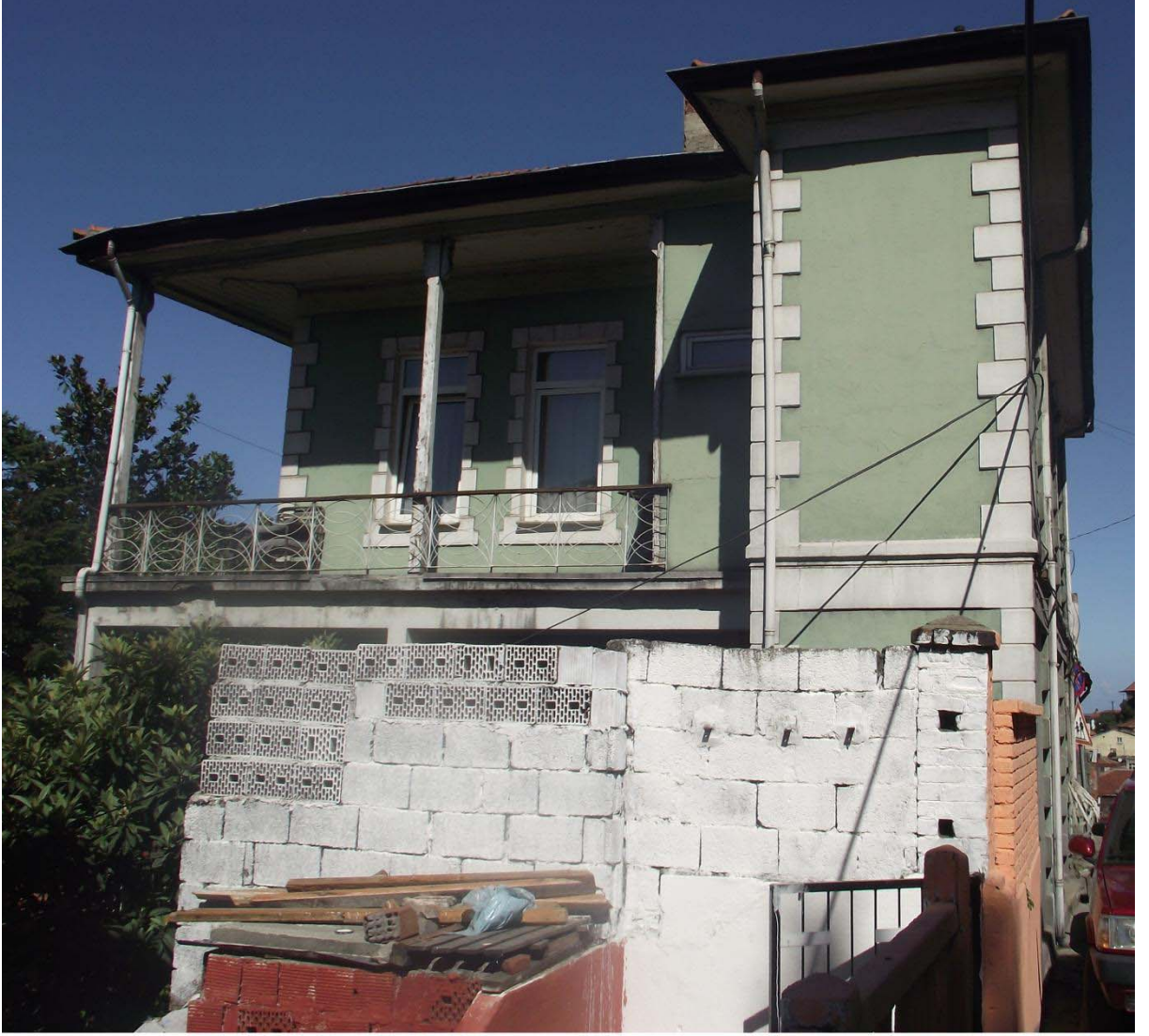
Resim 61: ZONGULDAK MERKEZ İLÇE II NOLU KONUT, Mithat Paşa Mahallesi, Sağlık Sokak, No: 8, Pafta: 8, Ada: 72, Parsel: 7, 19. Yüzyıl Sonu 20. Yüzyıl Baş, Batı Cephe
