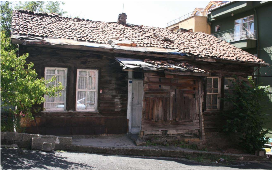
Resim 57: I Nolu Konut Mithat Paşa Mahallesi Namık Kemal Sokak, Pafta: 8, Ada: 63, Parsel: 1, 19. Yüzyıl, Yapının Kuzey Cephesi ve Giriş Cephesinin Görünümü
