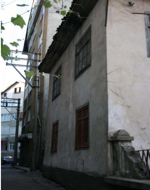
Resim 69: ZONGULDAK DEVREK İLÇESİ I NOLU KONUT, Eski Mahalle, Kocakuş Sokak, No: 8, 20. Yüzyıl, Doğu Cephe
