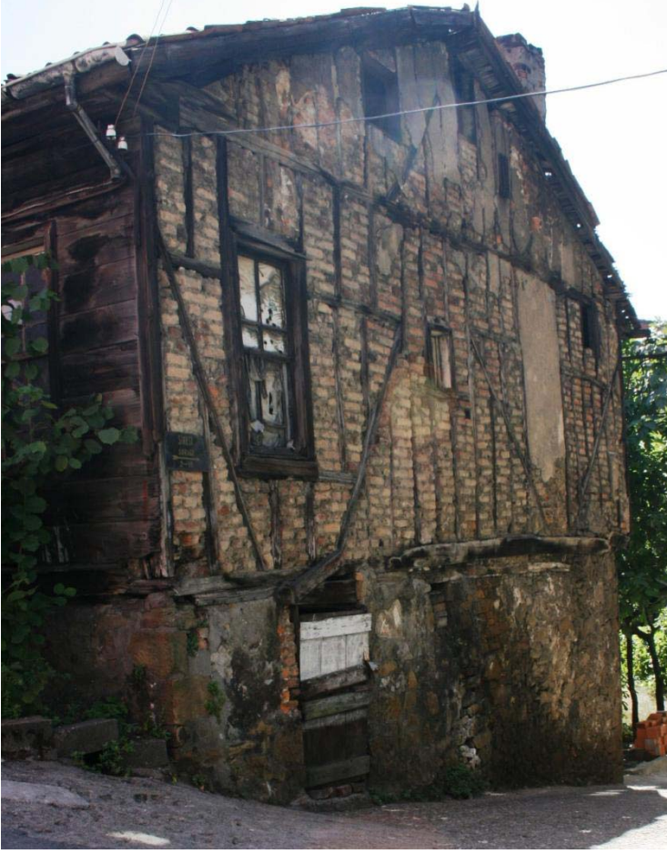
Resim 58: I Nolu Konut Mithat Paşa Mahallesi Namık Kemal Sokak, Pafta: 8, Ada: 63, Parsel: 1, 19. Yüzyıl, Yapının Doğu Cephesinin ve Hımişli Sistemdeki Duvarın Görünümü
