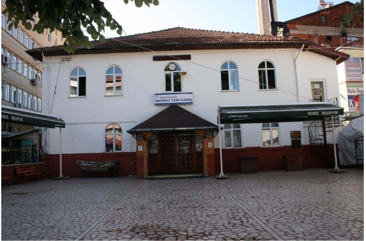
Resim 19: Devrek İlçesi Merkez Yeni Cami Kuzey Cephesi ve Avlusundan Görünüm
