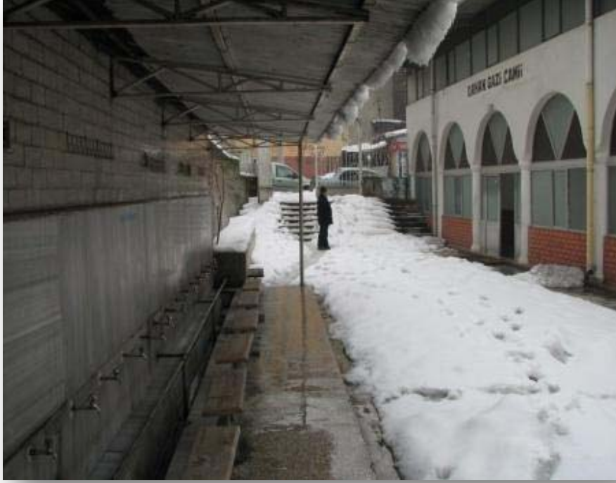
Resim 7: ZONGULDAK EREĞLİ İLÇESİ AYASOFYA KİLİSESİ (ORHAN GAZİ CAMİ), KUZEY CEPHE, AVLU ve ŞADIRVANDAN GÖRÜNÜM, Akarca Mahallesi, Orta Cami Caddesi, No:43
