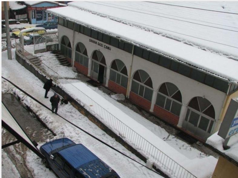
Resim 8: ZONGULDAK EREĞLİ İLÇESİ AYASOFYA KİLİSESİ (ORHAN GAZİ CAMİ), KUZEY CEPHE, AVLUDAN GÖRÜNÜM, Akarca Mahallesi, Orta Cami Caddesi, No:43
