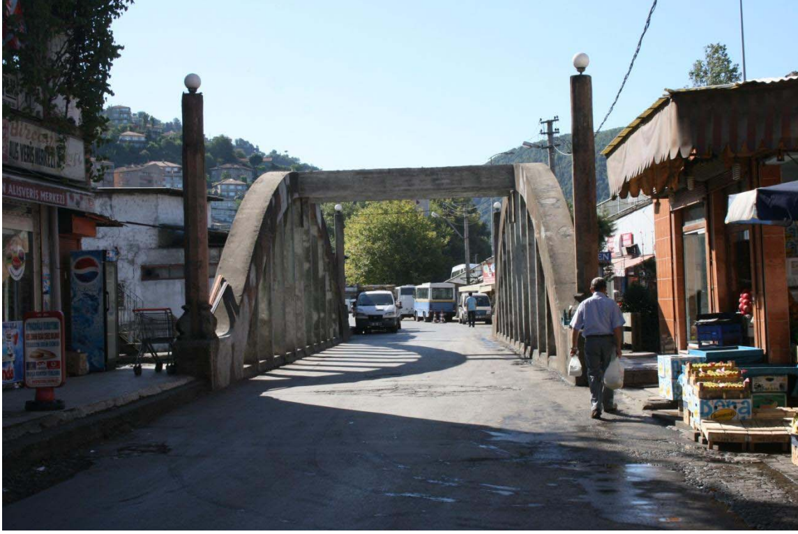
Resim 50: ZONGULDAK MERKEZ İLÇE ANKARA KÖPRÜSÜ, Meşrutiyet Mahallesi, Ankara Caddesi, 1930 (Erken Cumhuriyet Dönemi), Tabliye Bölmesinden ve Işılandırılmalarından Görünüm
