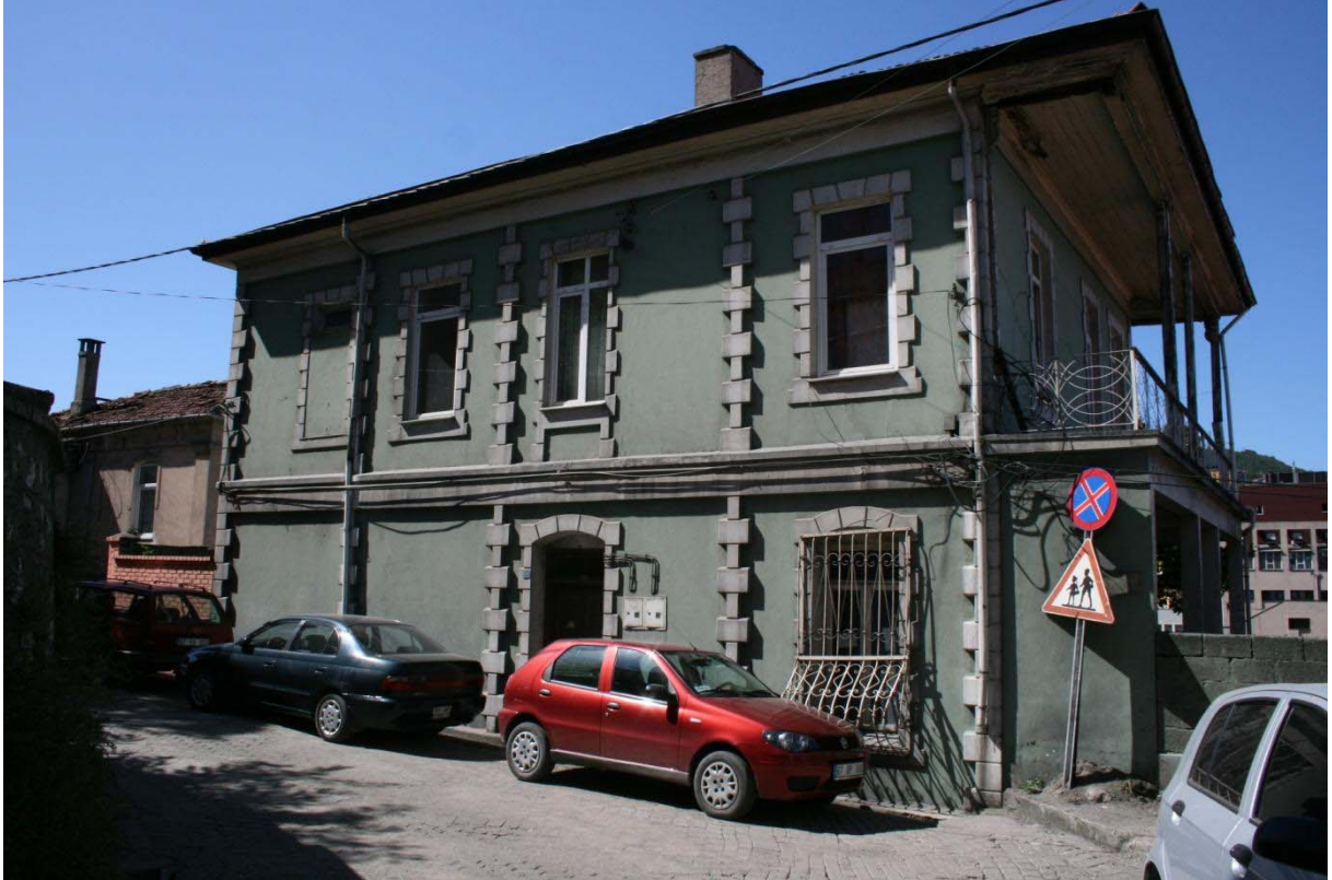
Resim 60: ZONGULDAK MERKEZ İLÇE II NOLU KONUT, Mithat Paşa Mahallesi, Sağlık Sokak, No: 8, Pafta: 8, Ada: 72, Parsel: 7, 19. Yüzyıl Sonu 20. Yüzyıl Başı, Güney Cephe Duvarı, Giriş Cephesi ve Doğu Cephesi
