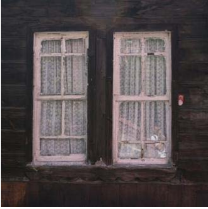
Resim 60: I Nolu Konut Mithat Paşa Mahallesi Namık Kemal Sokak, Pafta: 8, Ada: 63, Parsel: 1, 19. Yüzyıl, Yapının Kuzey Cephesi ve Giriş Cephesinde Yer Alan Pencereden Görünüm
