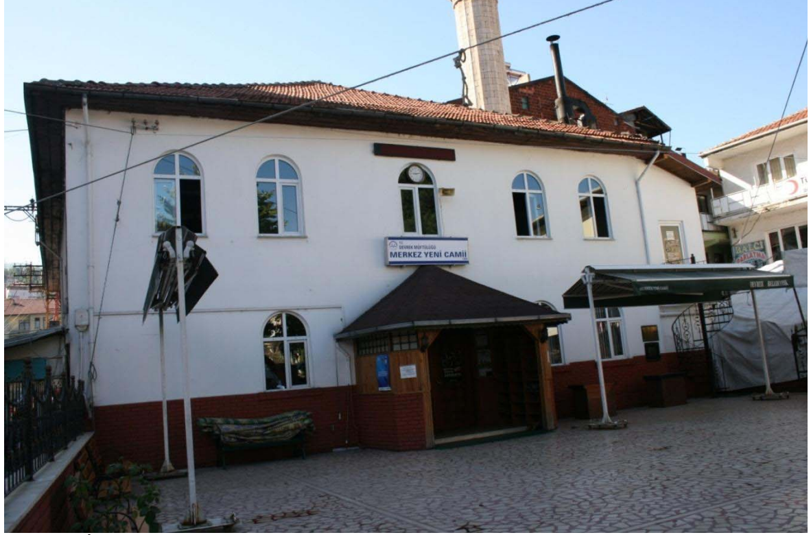
Resim 23: Devrek İlçesi Merkez Yeni Cami Kuzey Cephesinden Görünüm
