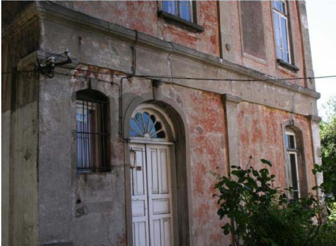
Resim 65: ZONGULDAK MERKEZ İLÇE III NOLU KONUT, Mithat Paşa Mahallesi, Mehmet Ali Sokak, No: 6 / A, Pafta: 4, Ada: 367, Parsel: 99, 20. Yüzyıl Başı, Doğu Cephe
