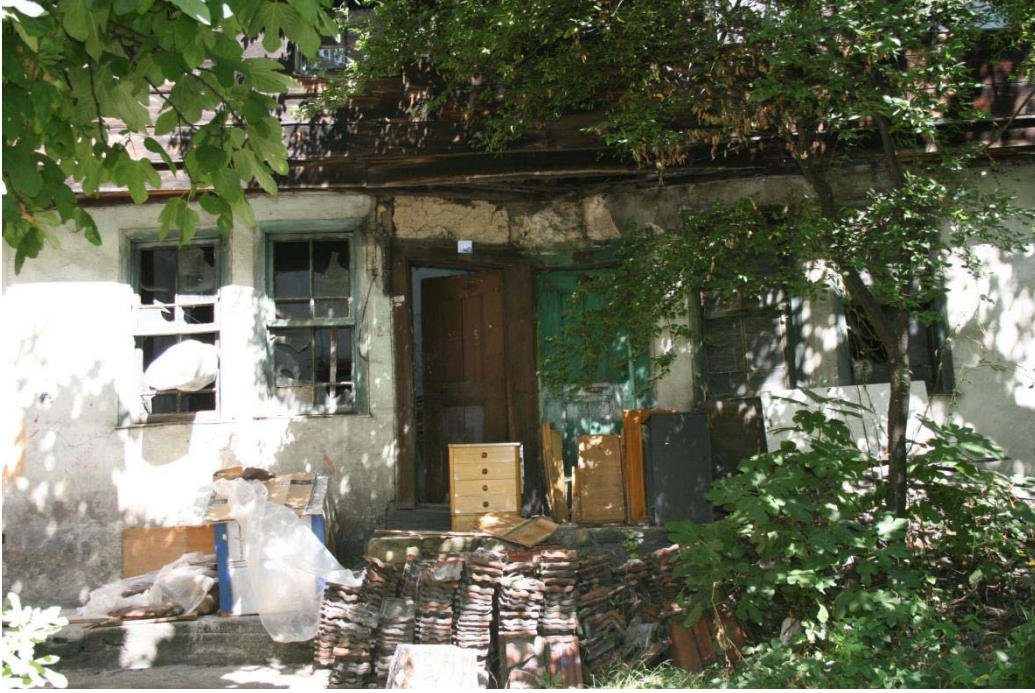
Resim 59: I Nolu Konut Mithat Paşa Mahallesi Namık Kemal Sokak, Pafta: 8, Ada: 63, Parsel: 1, 19. Yüzyıl, Yapının Güney Cephesi ve Zemin Kat Giriş Cephesinin Görünümü
