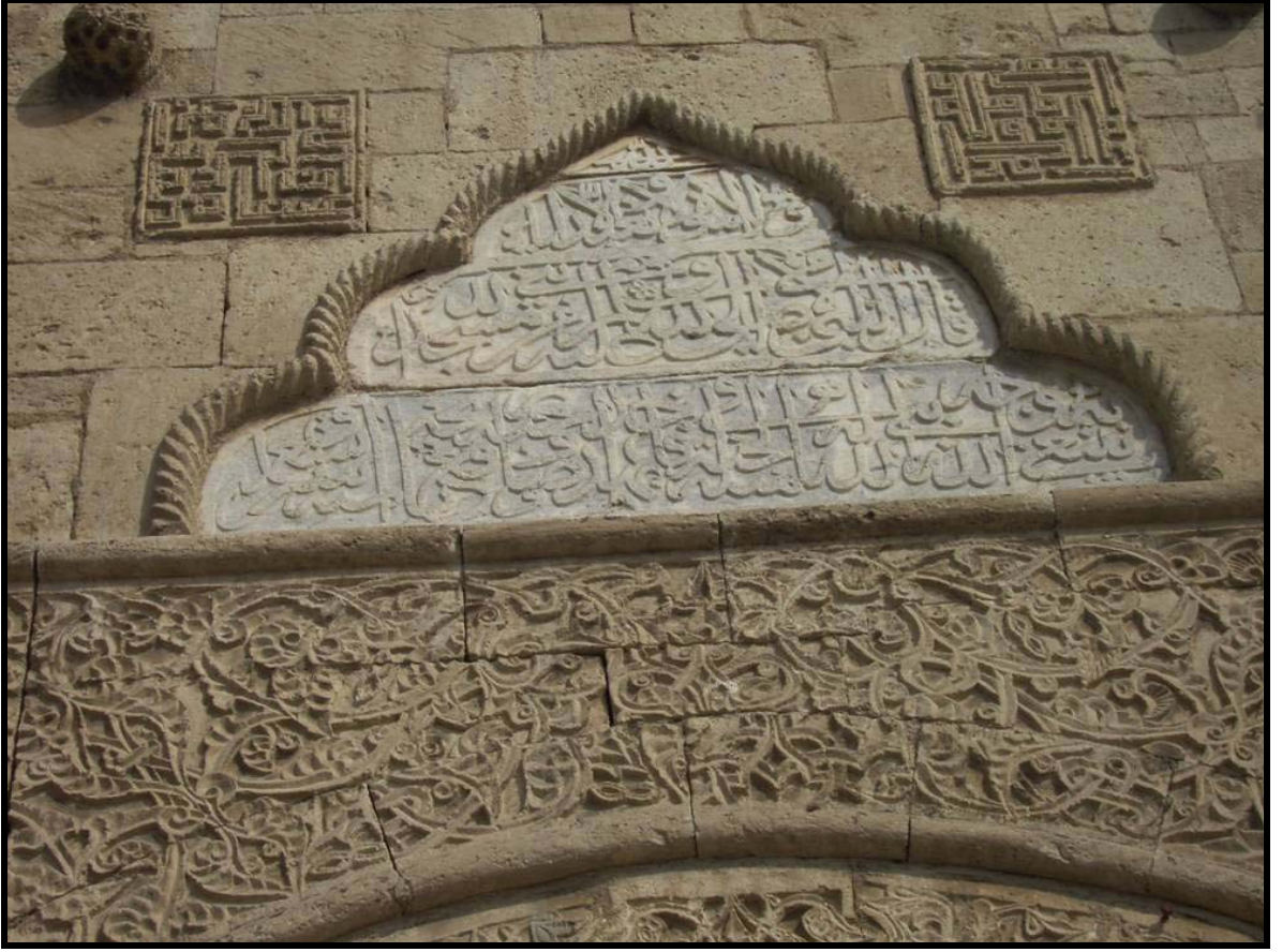
Şekil 2.16. Hacıbeyler Camiinin Kitabesi
